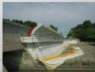
(6)背後コンクリート打設
