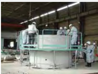
水平仮組試験
