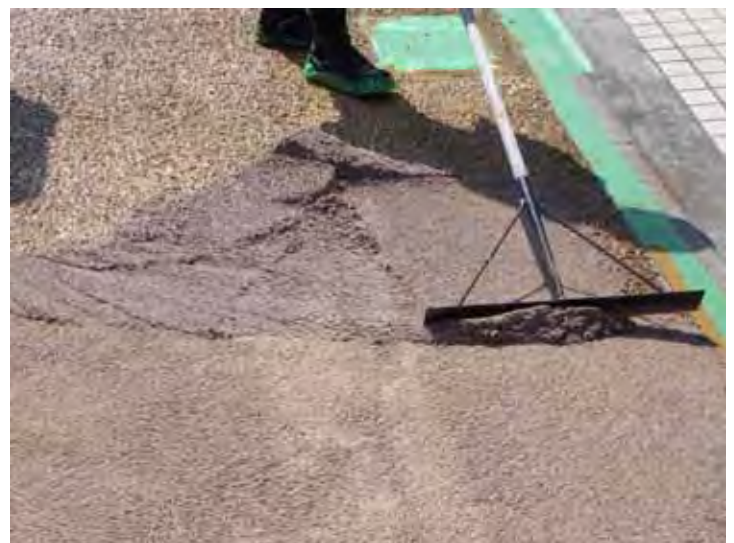
透水性レジンモルタルの敷設
