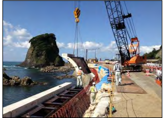
写真一2 施工中
