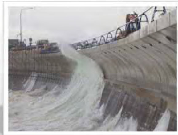
フレア護岸での波返し状況
