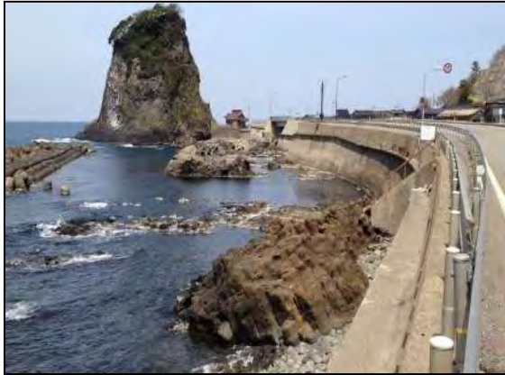
写真一1 施工前
