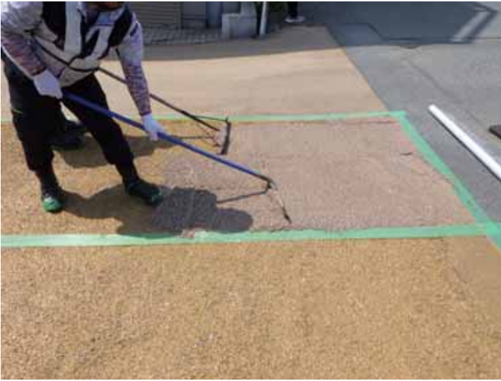
透水性レジンモルタルの敷設
