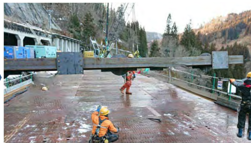
受桁取り付け
