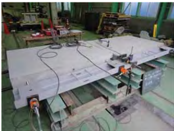
写真3 RC平板供試体による挿入試験状況
