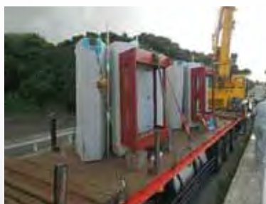
(2)上部フレアブロック搬入
