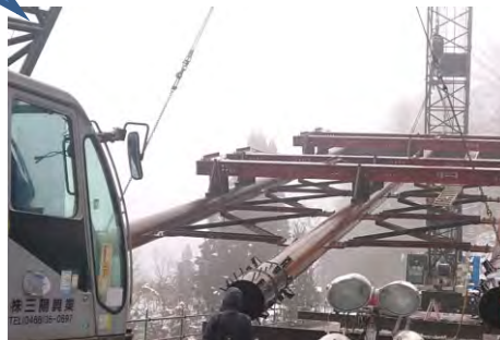
下部ユニット一括吊上げ
