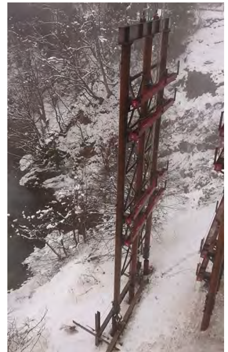
下杭への取り付け
