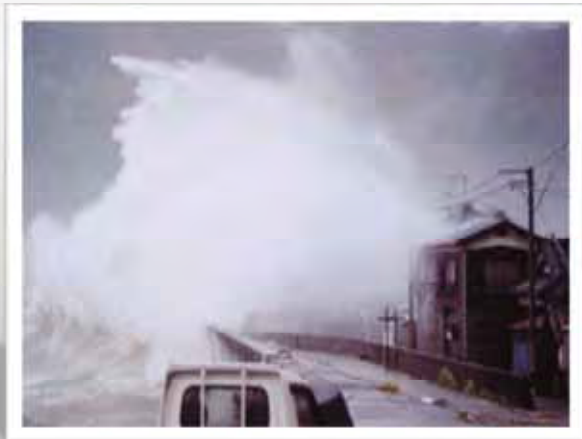
従来の護岸形式での被害状況
