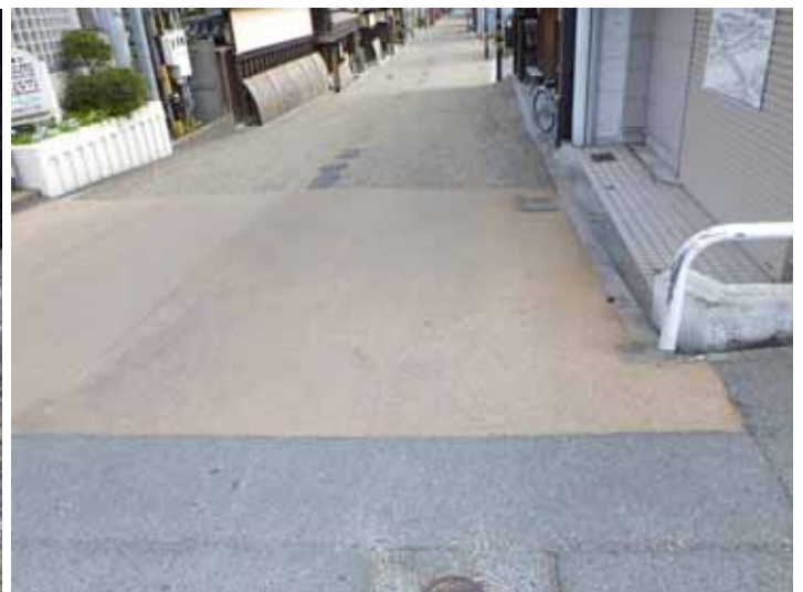
PRMSカラー工法で補修後3か月経過
