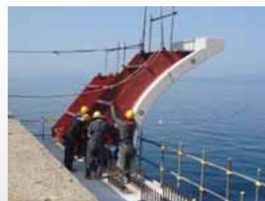
(3)上部フレアブロック据付
