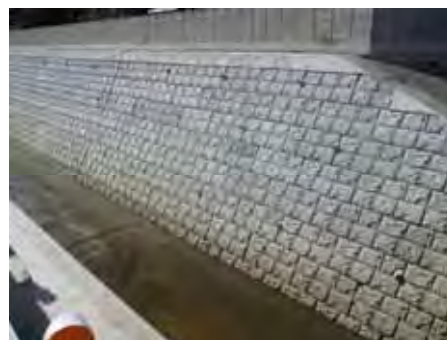
現場 西川川災害防止対策工事 施主 嘉麻市役所
