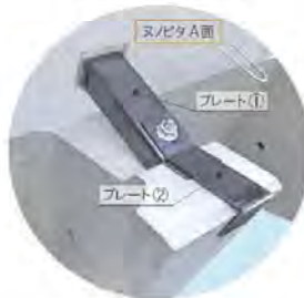
控プレートの取り付け
