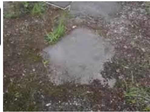
2019年8月撮影 (施工5か月後)
