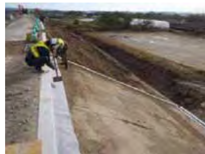
③ゴビマット遮水原反をコンクリートに接着
