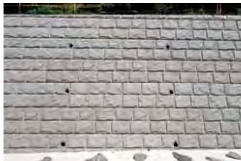
ブロック敷設 (正面)
