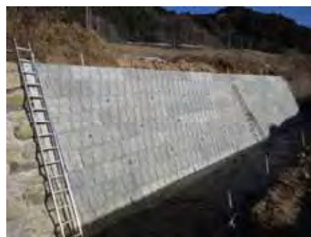
現場 畑川河川災害復旧工事 施主 嘉麻市役所
