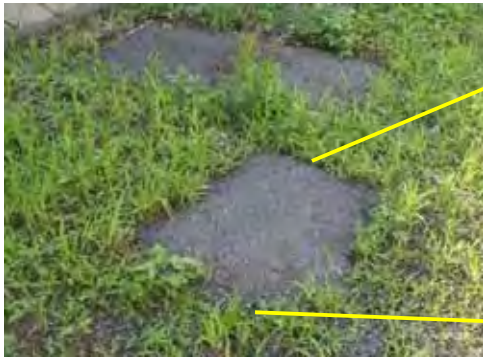
2021年6月撮影 (施工2年3か月後)
