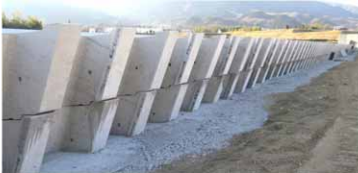
ブロック敷設 (背面)
