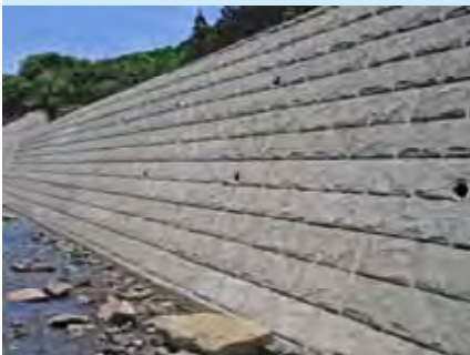
ブロック敷設 (全景)
