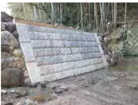
現場 鳴戸川災害復旧工事 施主 飯塚市役所
