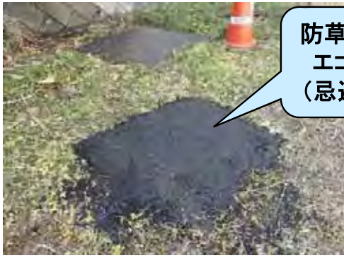
2019年3月撮影 (施工直後)
