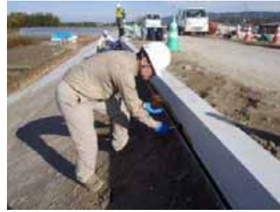
①コンクリート部分に接着剤を塗布
