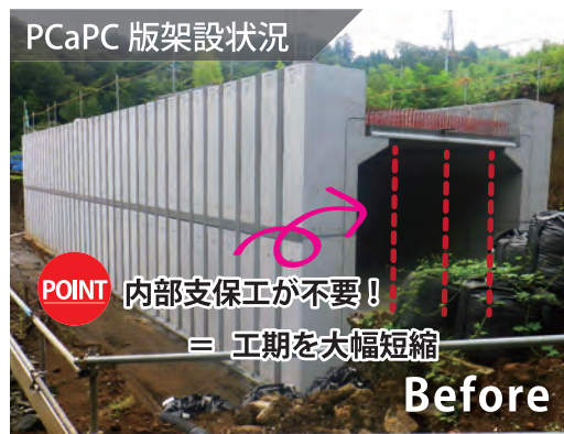
図1 ■コンポジットカルバート 2連タイプ B13000×H6000×2 連イメージ ※イメージです。形状は実際と異なる場合があります。
