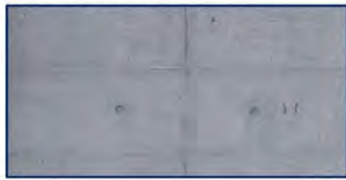
塩分濃度測定対象のコンクリート面
