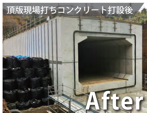
写真1 ■コンポジットカルバート頂版施工状況
