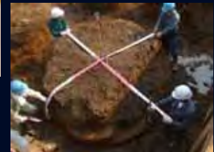
固結状況開削確認 (直径2.5m)
