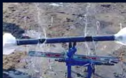
注入外管吐出状況
