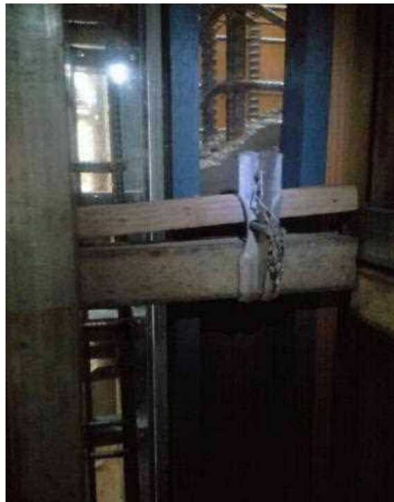
構造スリット型枠(打設中)
