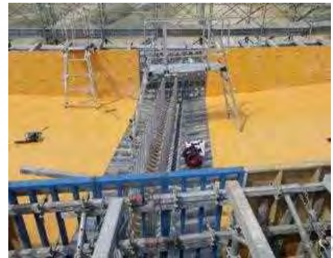
上部工工事（壁式橋脚との取り合い部）
