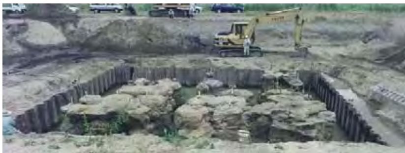
写真-3 1999年 固結状況開削確認
