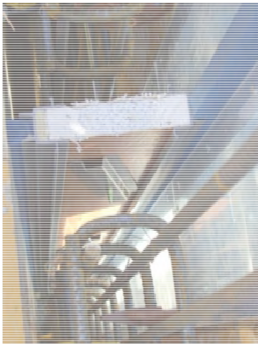
構造スリット型枠
