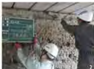
プライマー処理
