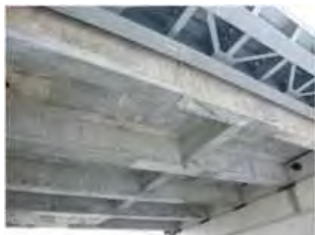
施工例 (床版下面の補修)
