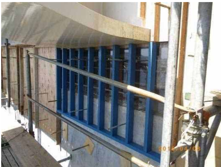
鋼製桁と下部工のジョイント部 の根巻型枠
