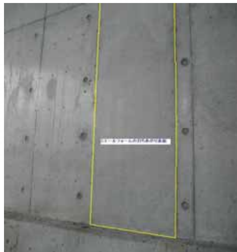
コンクリート 打ち上り
