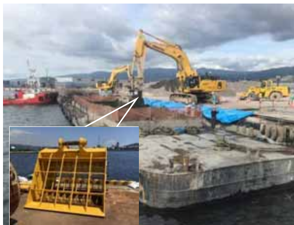
函館港でのカルシアバケット活用状況
