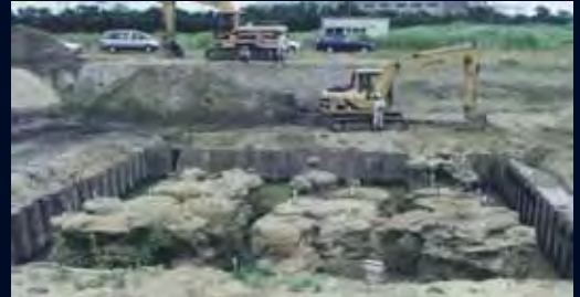
1999年 固結状況開削確認
