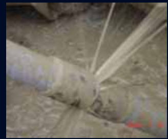
懸濁型グラウト吐出状況
