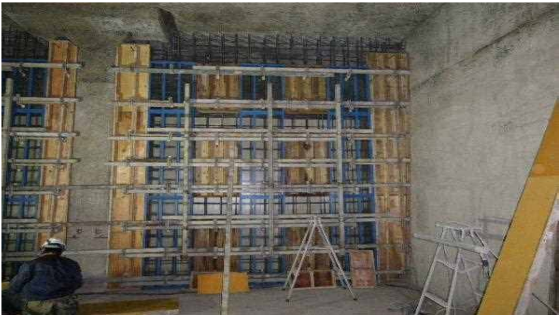
浄水場の後打ち間仕切り壁型枠
