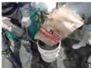
材料の混練 (ハンドミキサー等により攪拌)
