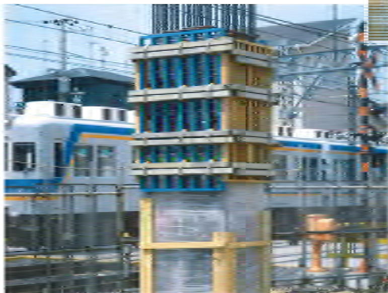
鉄道高架橋工事（ラーメン構造）
