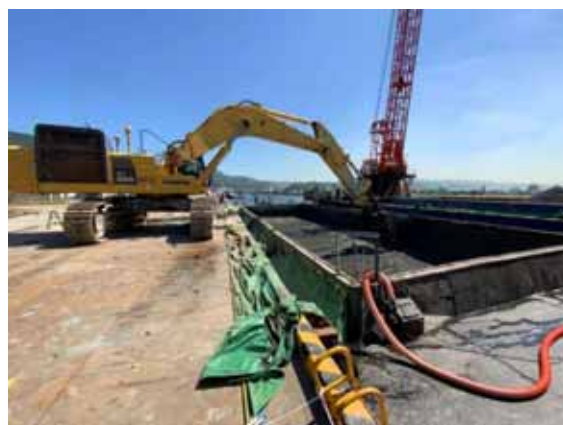
図-5 カルシアバケット現場利用状況
