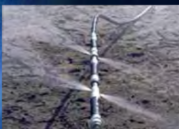
注入内管吐出状況(トリプルパッカ)
