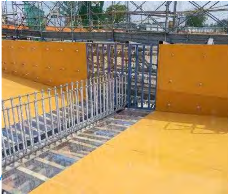
上部工工事（壁式橋脚との取り合い部）
