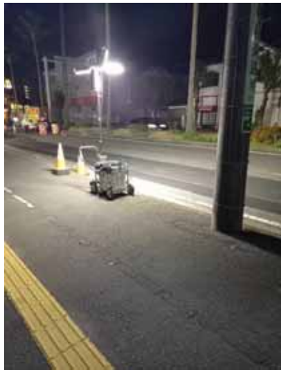
県道341号線工事
