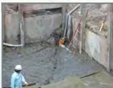
ポンプによる釜場処理
