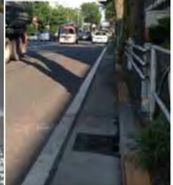
相武国道事務所
