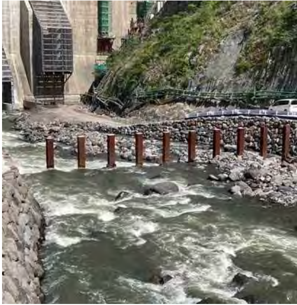
国)立野ダム工事事務所 流水型流木止 規模：高さ5.0m 幅25.0m 鋼管：□-500×16
