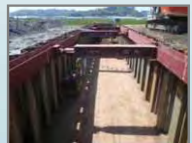
鋼矢板による遮水処理
