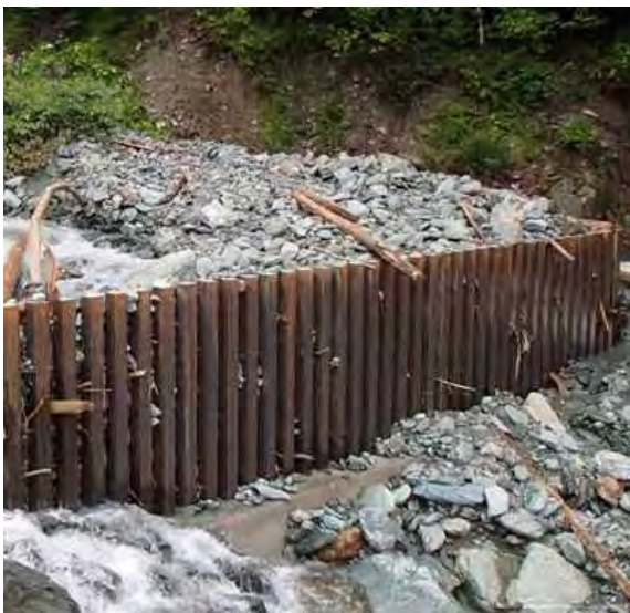
林)徳島森林管理署 祖谷川地区／規模：高さ3.0m、開口幅16.2m 2021年5月 豪雨(1時間あたり40mm程度)により上流域に堆砂していた流木・土石が流出。 VCGO型応急対策工がこれを食い止め、下流域で実施している治山ダム工事現場への被害を防止。
