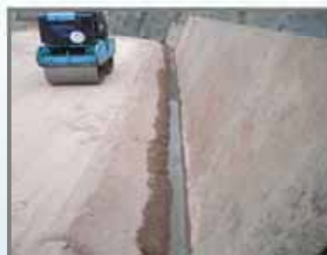
溝切りによる排水処理
