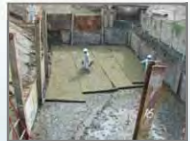
土木シートによる 練返し防止対策
