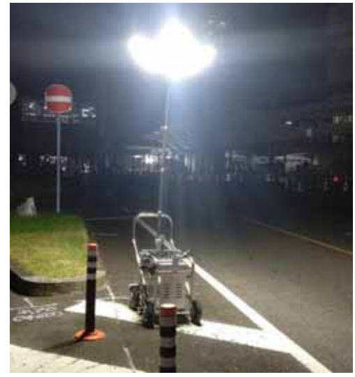
宮崎駅前口一タリ一舗装工事
