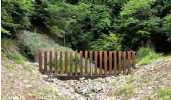
見切沢応急対策工全景
