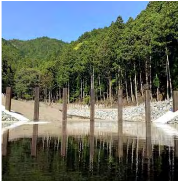
独) 水資源機構 小石原川ダム流木止 規模：高さ3.5m 幅21.0m 鋼管：□-450×16
