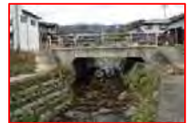
ボックスカルバートの基礎
