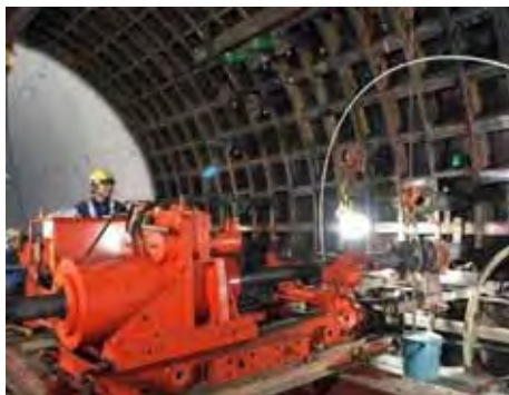
凍結管設置状況
