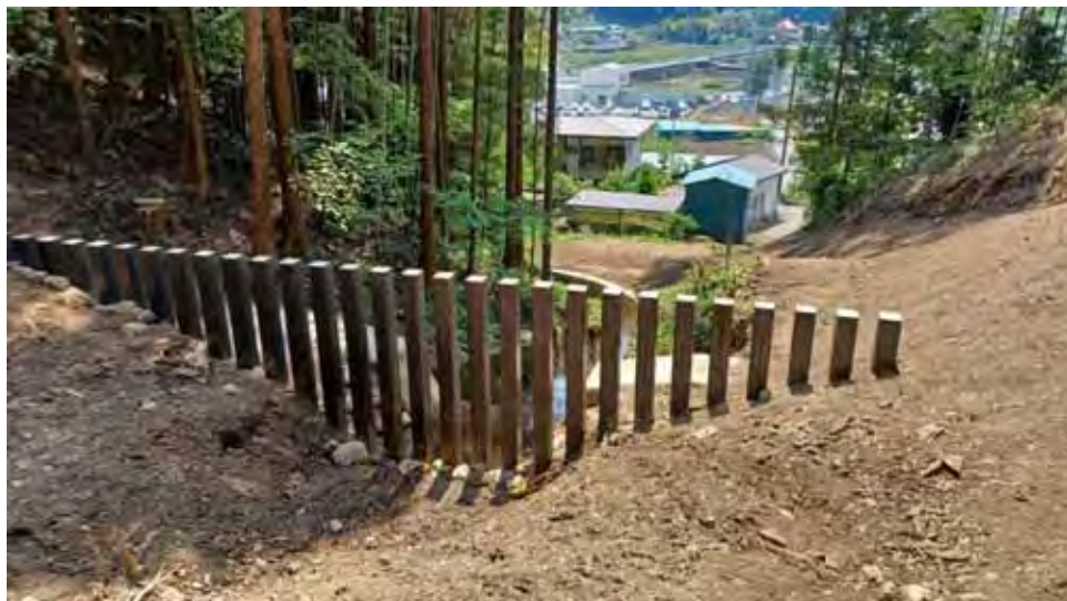
群馬県 高崎土木事務所 堀谷戸沢 規模：高さ3m 開口幅12.2m 鋼管：□-200×6
