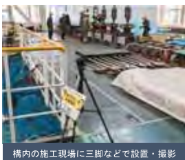
構内の施工現場に三脚などで設置・撮影
