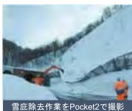
雪庇除去作業をPocket2で撮影
