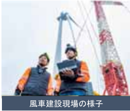
風車建設現場の様子
