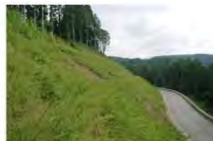
施工1年11カ月後
