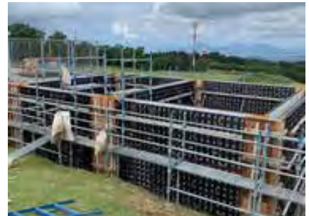
現場名：阿蘇ミルク牧場 沈殿槽 新設工事 建設会社：株式会社サンワイテック 施工業者：株式会社鶴田工務店
