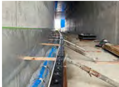
現場名：西区花園2丁目 島崎6丁目配管布設工事 建設会社：旭設備工業株式会社 施工業者：株式会社鶴田工務店
