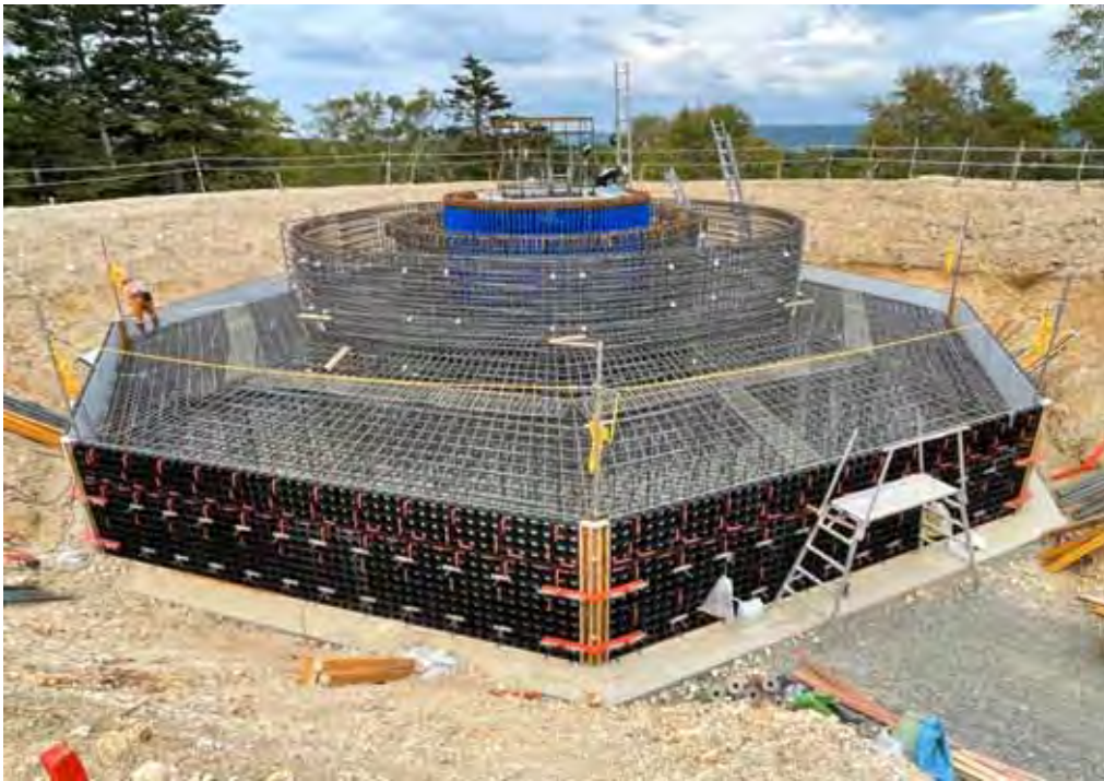
北海道稚内市 道北風力発電 川西WF 基礎 (八角形)
