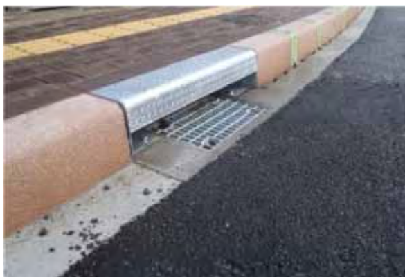
▲グレーチング部鋼製カバー
