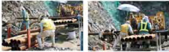
作業員2名 人力で運搬
