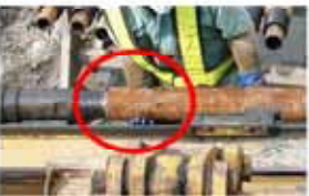
捲込まれ注意箇所
