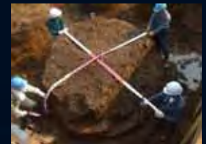
固結状況開削確認 (直径2.5m)
