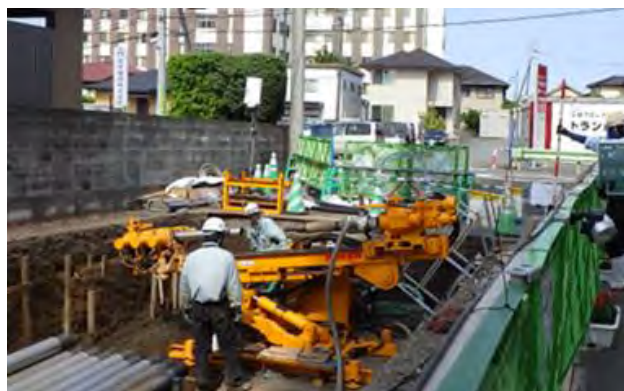
写真-2 宅地直下地盤の液状化対策
