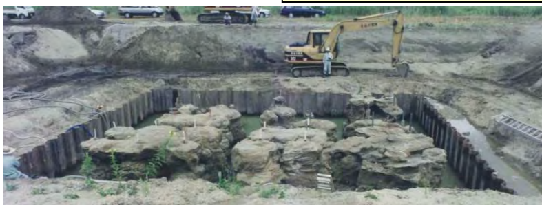
写真-5 1999年 固結状況開削確認
