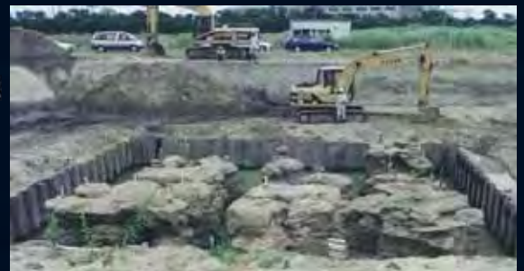
1999年 固結状況開削確認
