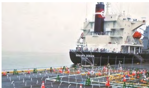
写真-3 注入管設置状況
