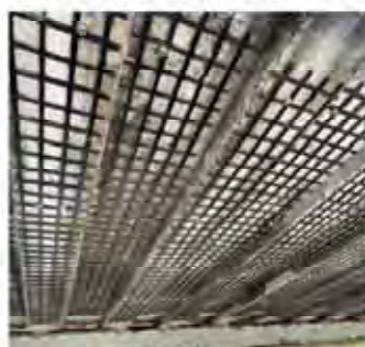
駅ホーム 下面コンクリート
