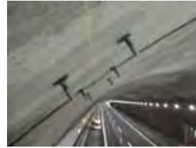
トンネル工事
