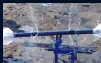
注入外管吐出状況
