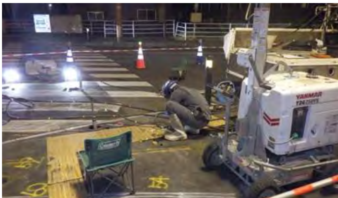
写真-1 住宅地の液状化対策
