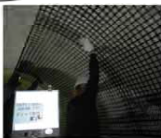
トンネル グリッド設置工
