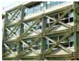
建築耐震補強
