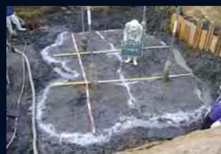
固結状況開削確認
