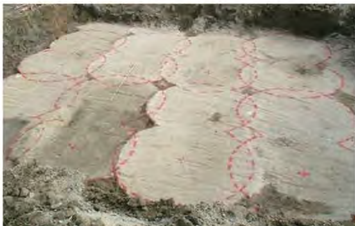
改良体ラップ状況
