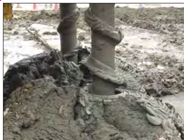
投入セメント量に見合う、原土の排出
