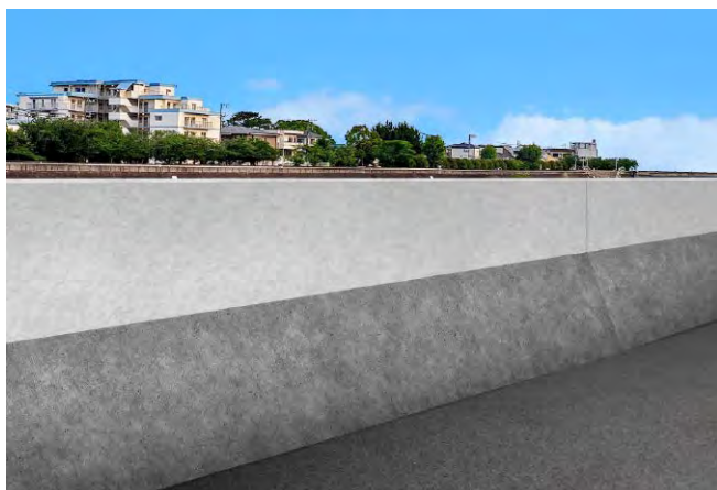
コンクリート壁による嵩上げ
