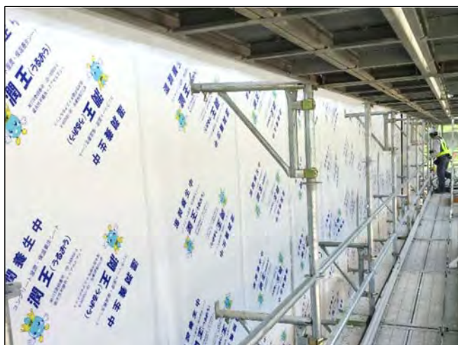
写真-3 施工事例(鉛直面)
