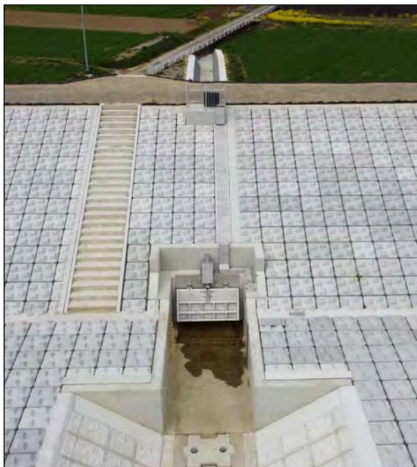
正伝寺川樋門 W2.60m×H1.30m×1式 (肱川激甚災害対策特別緊急工事)
