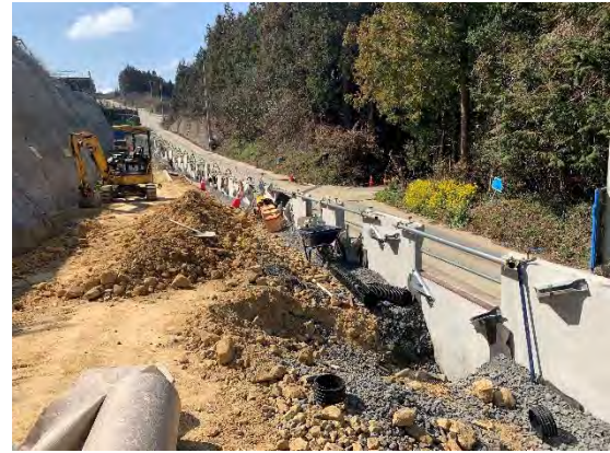
施工中の多数アンカー式補強土壁
