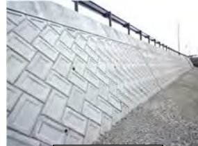
ブロック積擁壁
