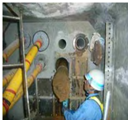
写真-3 マンホール内到達状況
