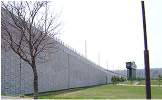
多数アンカー式補強土壁の外観
