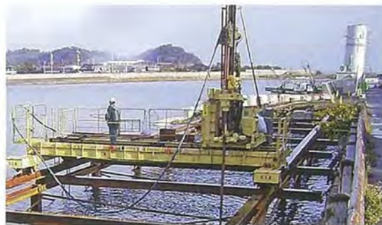
簡易足場での施工
