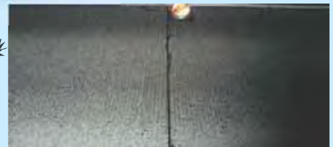
目地部の補修
