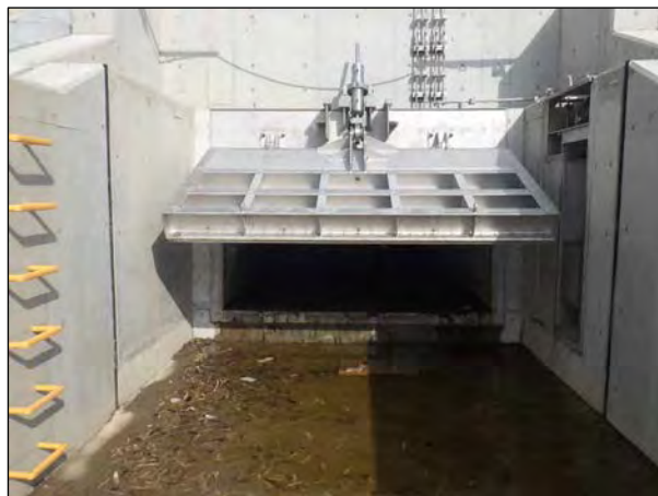
正伝寺川樋門 W2.60m×H1.30m×1式 (肱川激甚災害対策特別緊急工事)
