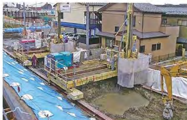
スライドベース施工
