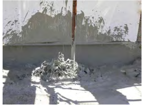
二重管、三重管工法施工時
