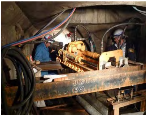
写真-2 マンホール内施工状況
