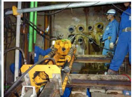
写真-4 上り勾配施工状況
