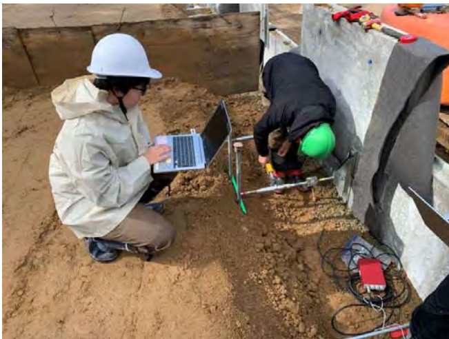
ターンバックルのトルク値の計測状況(1)
