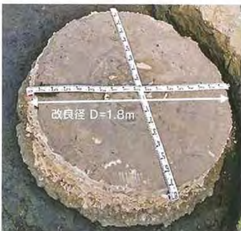
改良体出来形
