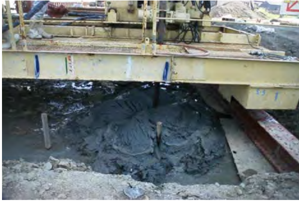
単管工法施工時
