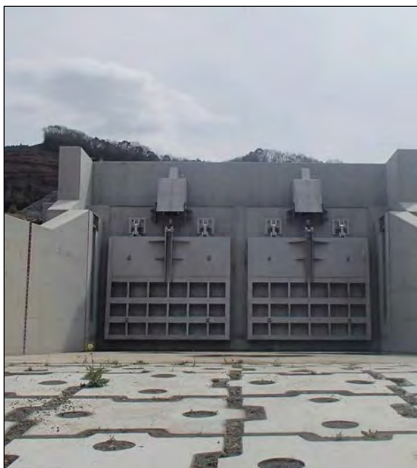
篠谷川樋門(左) W3.80m×H3.20m×2式 郷頭川樋門(上) W6.10m×H3.30m×1式 (肱川激甚災害対策特別緊急工事)
