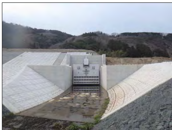
篠谷川樋門(左) W3.80m×H3.20m×2式 郷頭川樋門(上) W6.10m×H3.30m×1式 (肱川激甚災害対策特別緊急工事)
