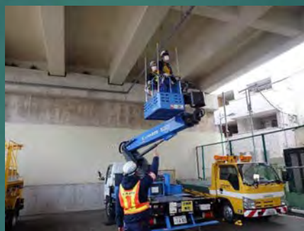
高所作業車の設置
