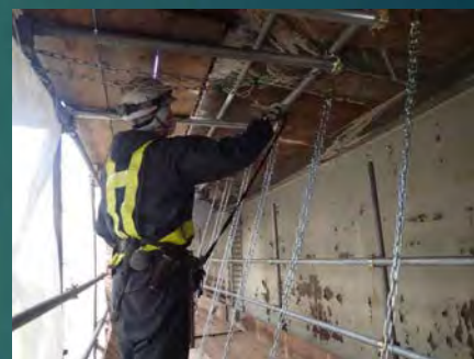
仮設足場の設置
