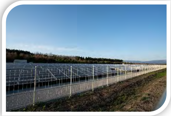
供用後の通路部防草
