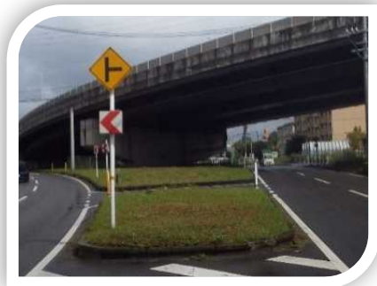
中央分離帯 施工前
