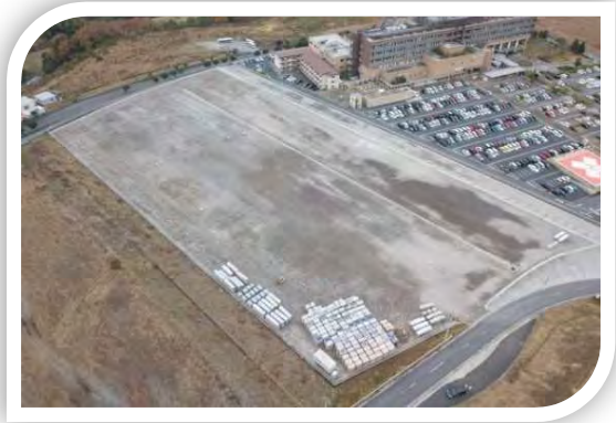
パネル設置前の全面防草
