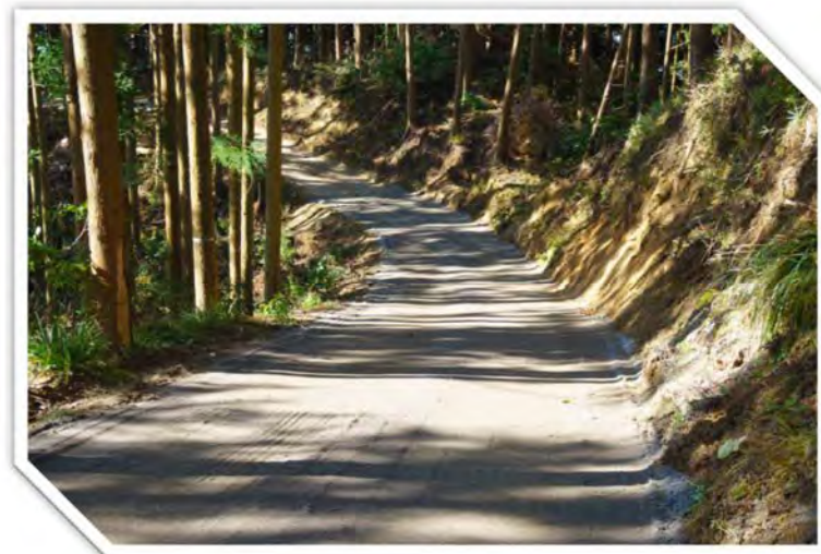
施工例：林道 （車両交通の少ない林道）
