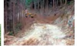
林道（作業道）施工前
