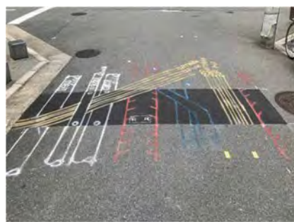
埋戻し後の路面マーキング
