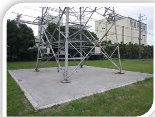
鉄塔下部の防草例
