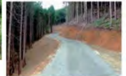
林道（作業道）施工後
