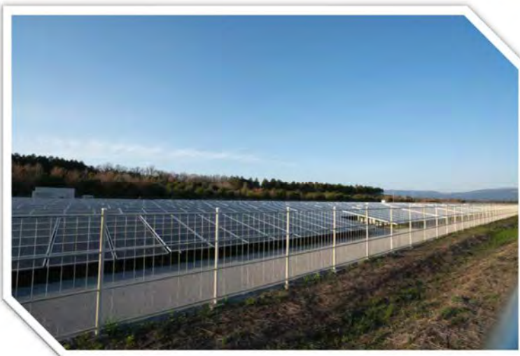
施工例：太陽光発電施設防草対策 （防草効果が求められる箇所）
