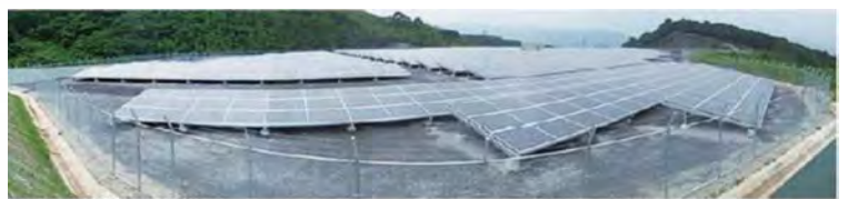
ソーラー発電所防草対策用施工例
