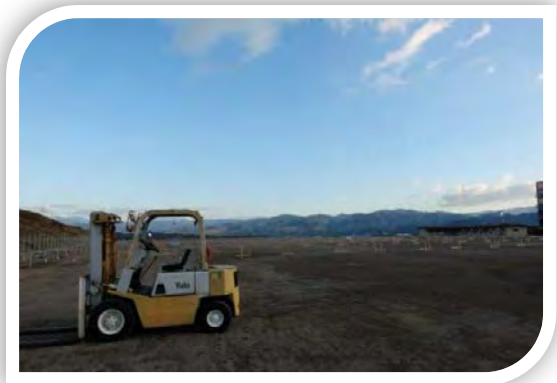
パネル設置前の全面防草
