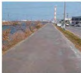
河川護岸天端管理道路
