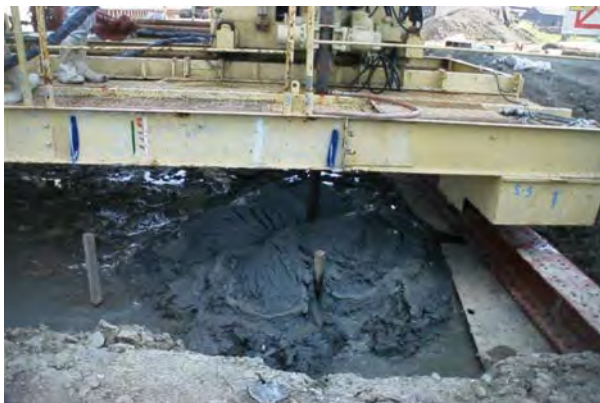
高圧スラリーのみ噴射するため排泥を伴わない
