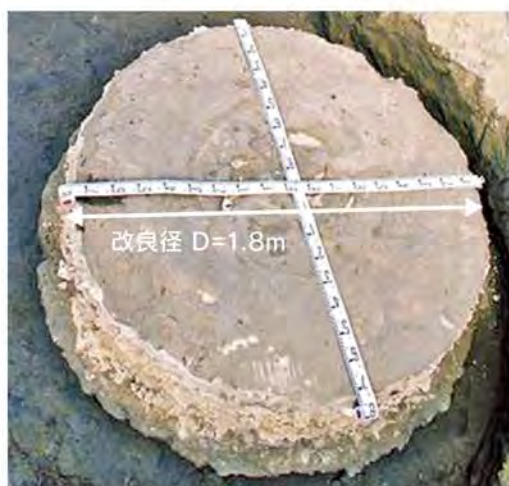
改良体出来形
