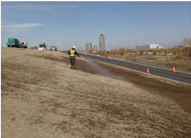
1バッチの散布範囲を決め2L/m 2 散布します。
