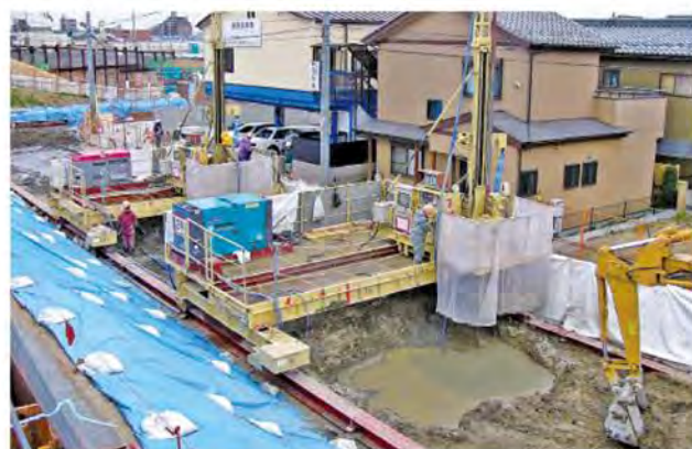
スライドベース施工
