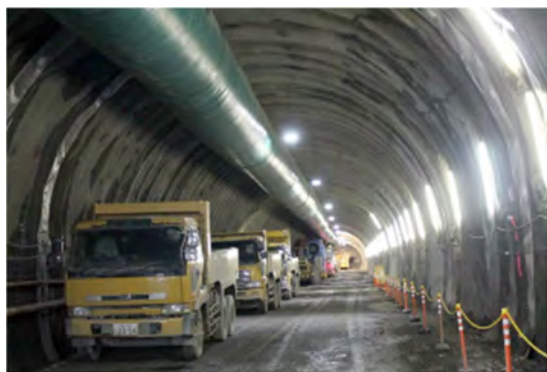
山岳トンネル
