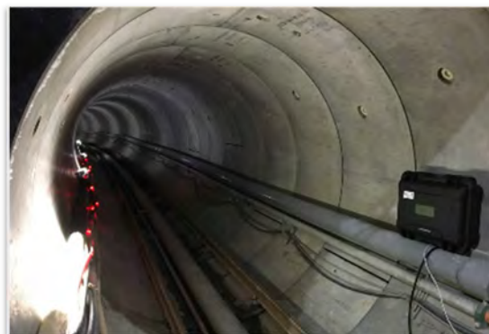
シールドトンネル
