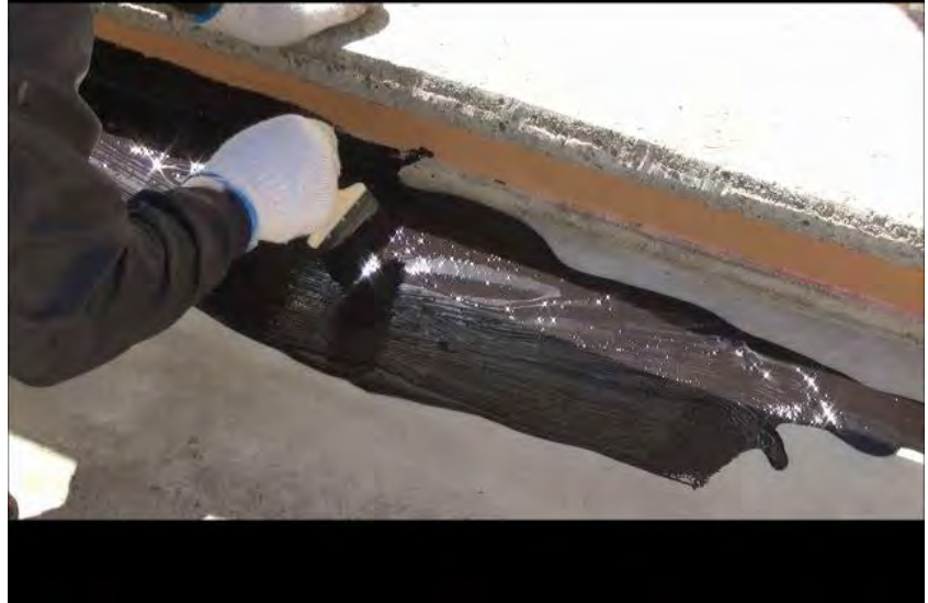
床版防水_端部処理
