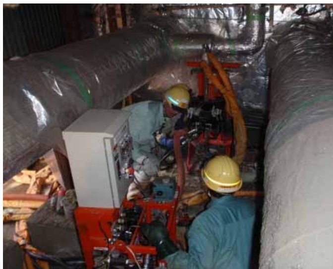
供用中の工場内での施工状況
