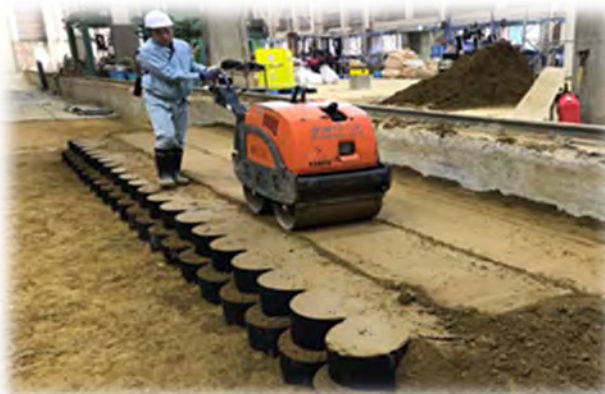
写真-3 ジオセル内外の確実な締りめ
