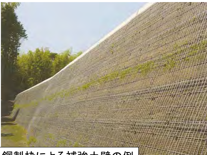
鋼製枠による補強土壁の例
