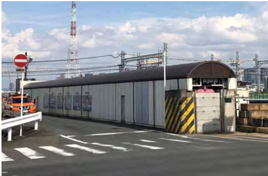
スライド式陸閘の格納庫
