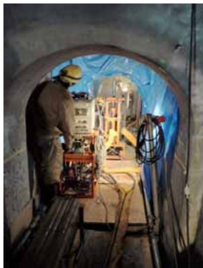
狭隘部での施工状況
