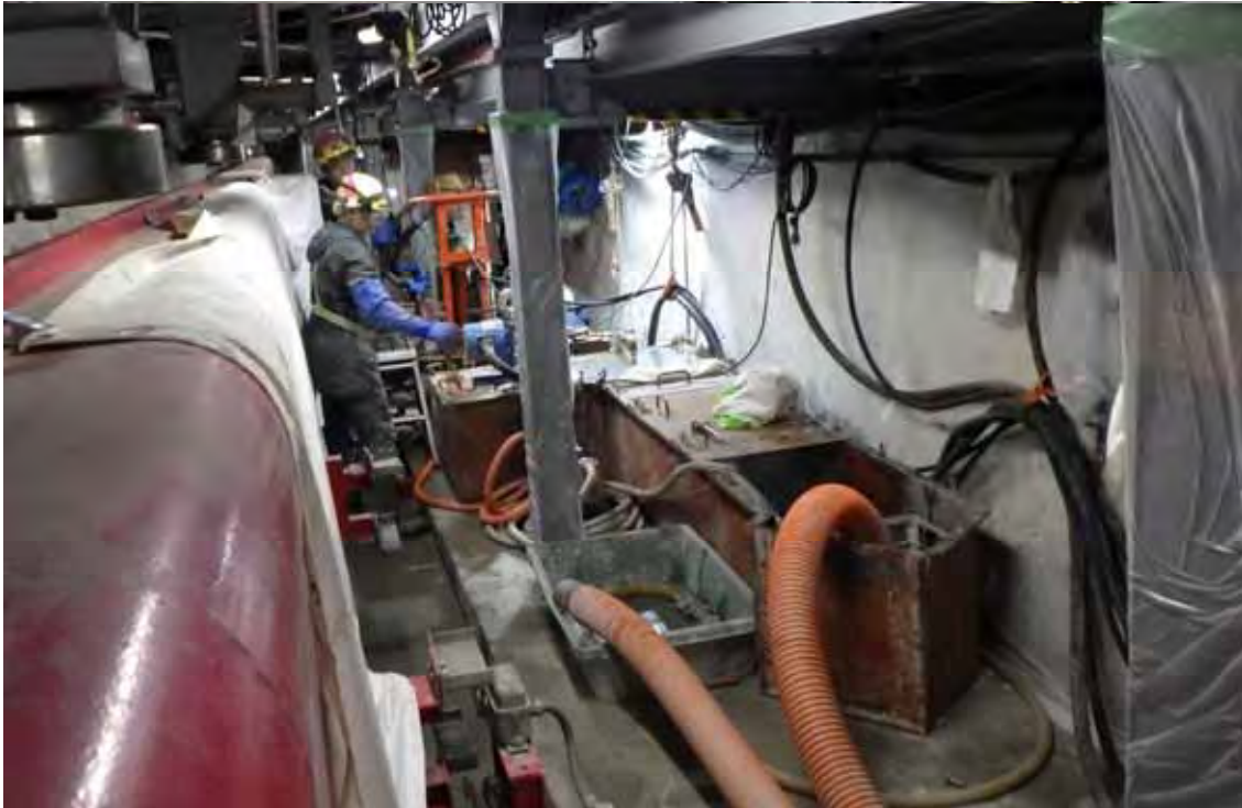
陸間格納庫内の様子
