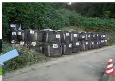
軽微な土留めに用いた事例
