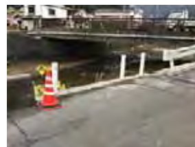
均しモルタル
