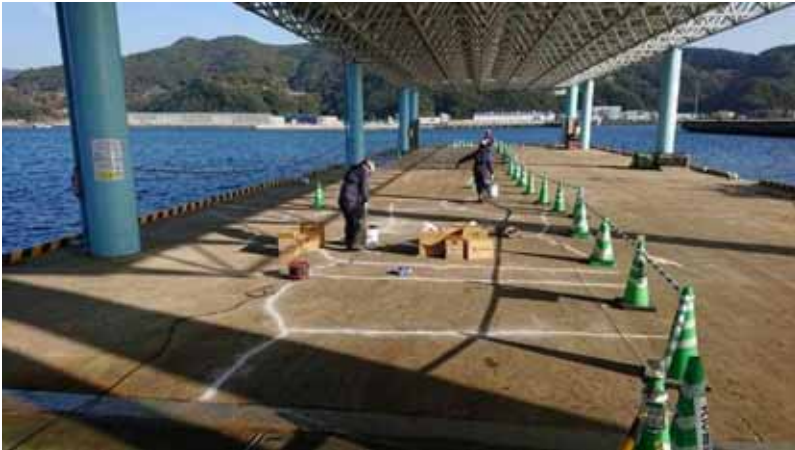
CS-21ビルダー塗布状況
