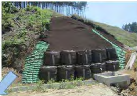
小崩壊の補修に用いた事例
