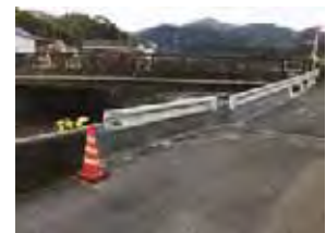
ガードレール取付け
