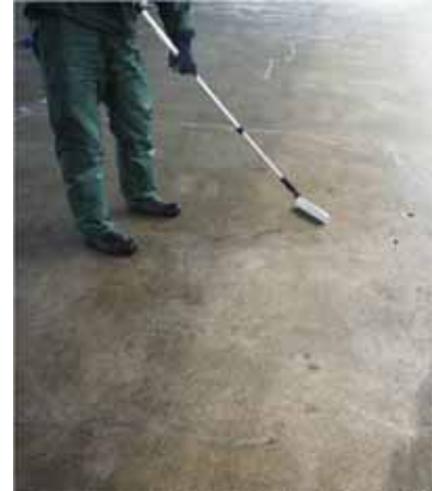
ローラー塗布状況
