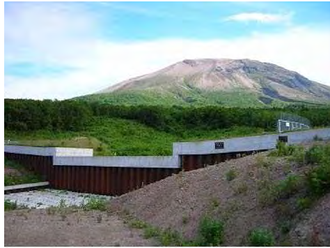
馬抛沢川砂溜工(2基の床固工にて形成)
