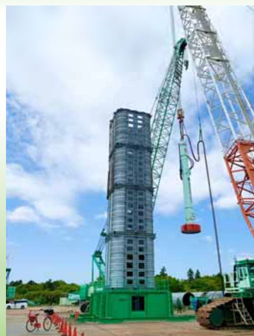
大型騒音防止装置（油圧ハンマS-350・500tクレーン）
