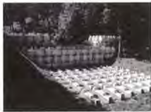
図-1 ブロック積砂防堰堤の施工事例 Fig.1 Example of a block sabo dam
