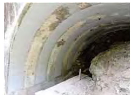
写真-3: 橋梁アーチ帯板状貼り
