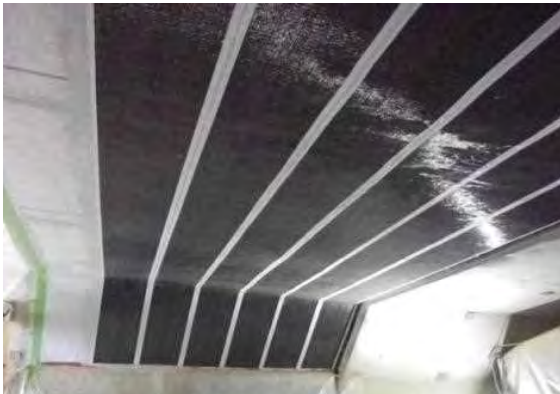
写真-6:BOXカルバート
