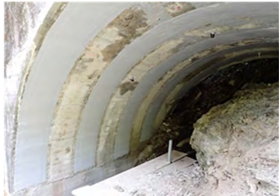
写真-7:橋梁アーチ部
