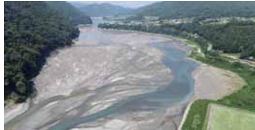
中部地整美和ダム（試験浚渫場所）
