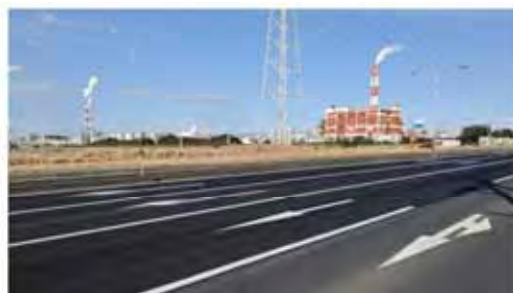
公共道路舗装
