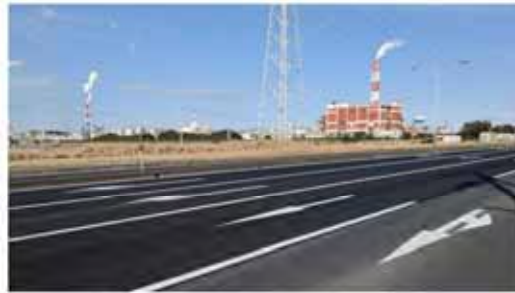
施工半年経過後
