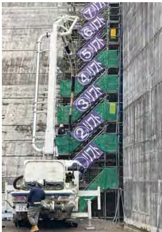
【コンクリート打設状況】
