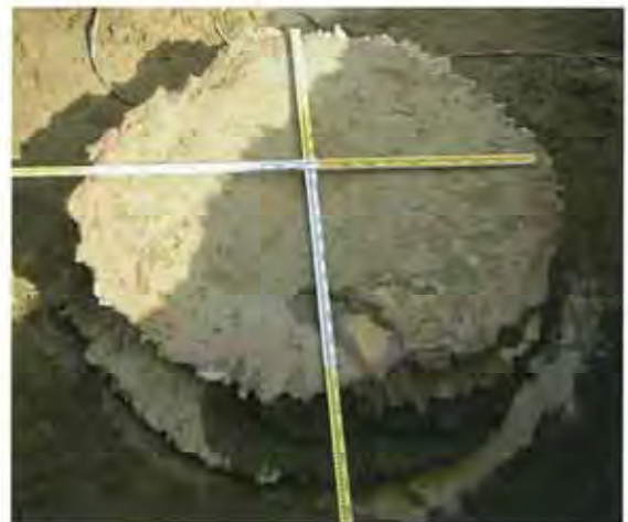
NJP-2way工法の改良杭
