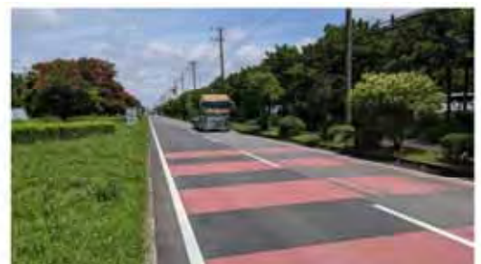
公共道路舗装
