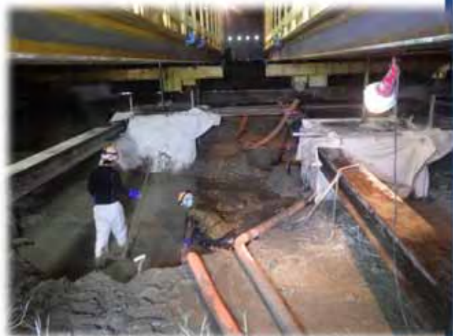
【発生土処理状況】
