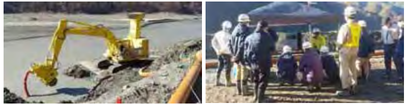
T-A Dredgerの試験浚渫状況(圧送距離500m・中継ポンプ使用)
