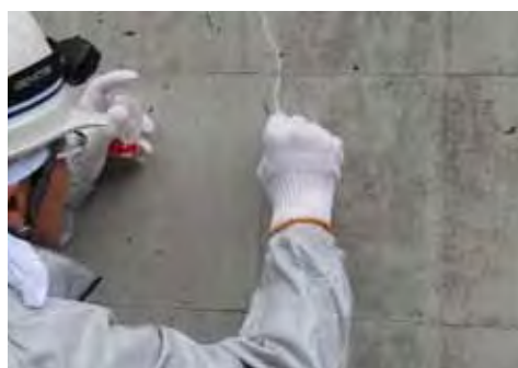
近接目視による従来点検方法
