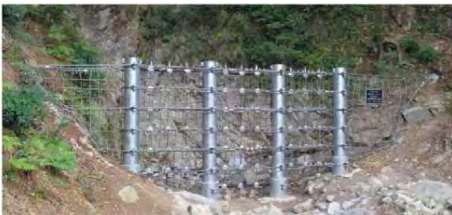
施工実績(熊本県球泉洞)
