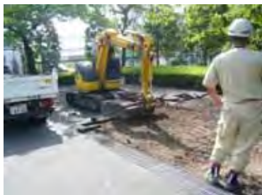
既設舗装版の撤去
