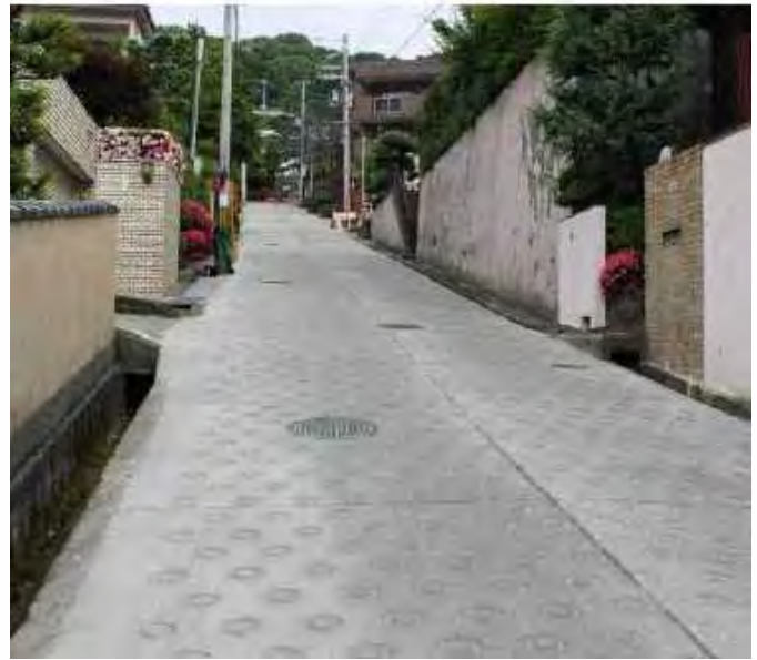
急勾配(26%)の施工 5
