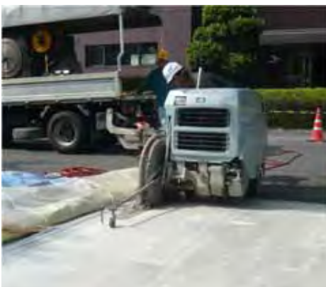
目地切 (カッター工)
