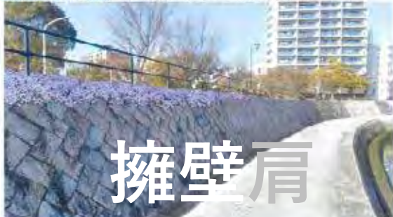
■擁壁上部への植栽 (擁壁肩から垂らすことで柔らかな景観に)
