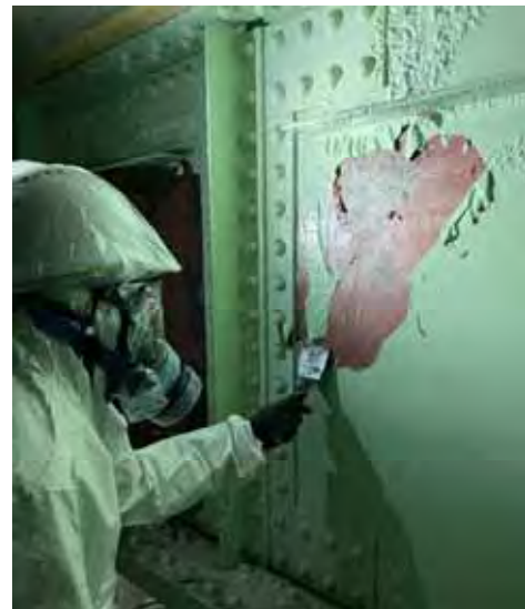
剥離剤を使用した塗膜除去作業での使用例
