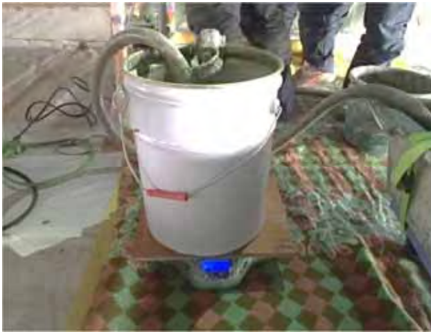
⑩注入後 残量確認
