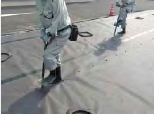
■開口掘削器具による開口掘削
