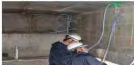
3.真空状態確認
