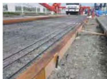
型枠、金物の設置
