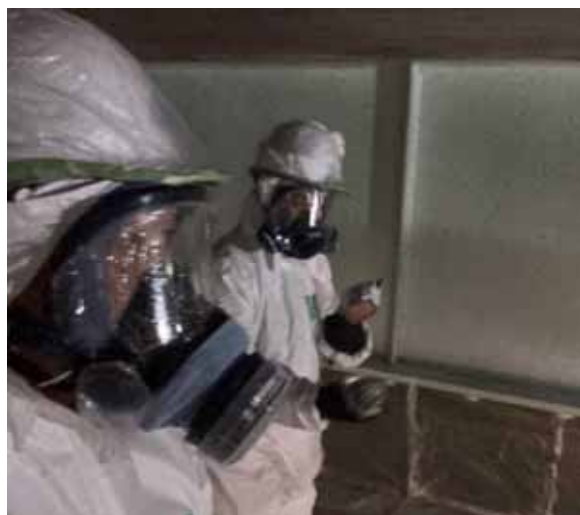
隔離養生した鋼橋塗替え現場での使用例
