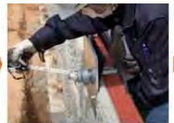
⑤ 診断用補強材（ロッド）の設置、仮締め
