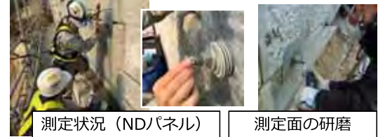
超音波探傷の例 (橋梁点検)
