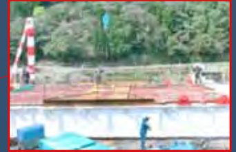
③ 地組作業（架設との並行作業）
