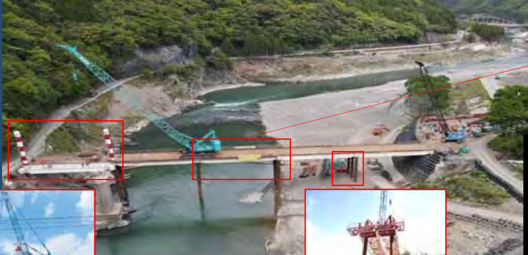
① 20m支間地組パネルの一括架設
