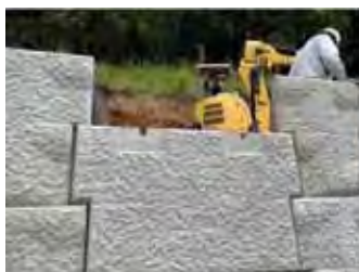
① 下側壁面材の設置
