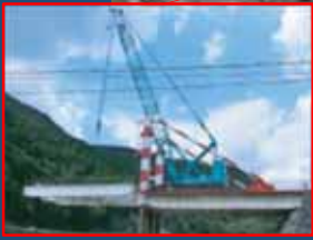
① 20m支間地組パネルの一括架設
