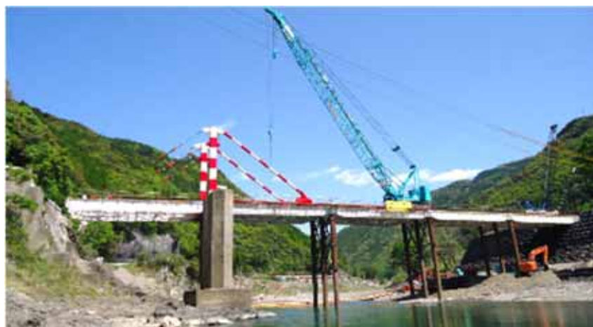
『上部工先行一括架設方式』における地組パネル架設（反力ポストによる支持）状況
