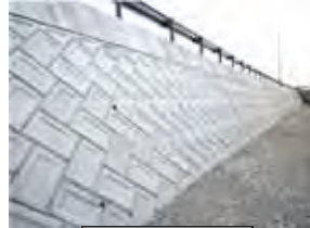
ブロック積擁壁
