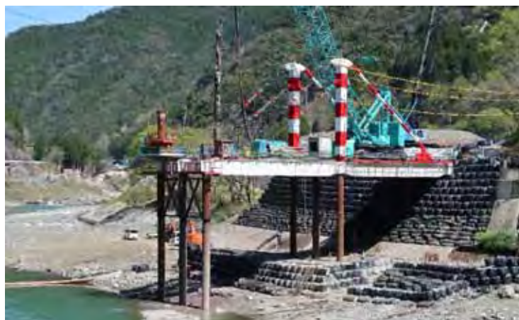
『上部工先行一括架設方式』における小型全周回転掘削機使用の支持杭打設（クレーンによる中掘り装置懸垂）状況
