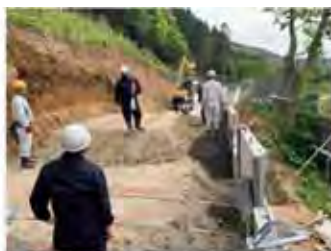
② 診断用補強材設置位置の撤き出し、敷均し、締固め
