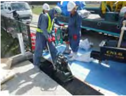
④プレートによる一次転圧
