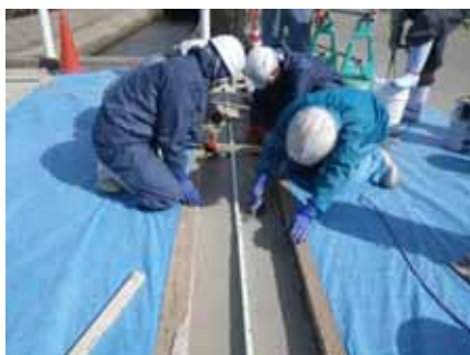
②不陸整正材打設敷均し
