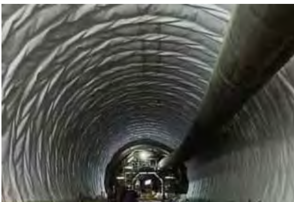
写真②: 北陸新幹線 深山トンネル
