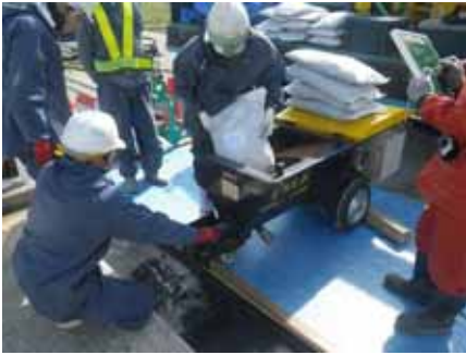
①破砕機による合材投入
