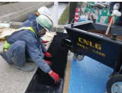
①破砕機による合材投入
