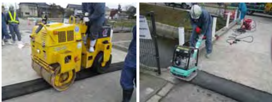
④コンバインドローラによる二次転圧 ⑤バイブロコンパクターによる三次転圧
