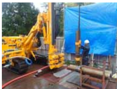
ケーシング取付状況
