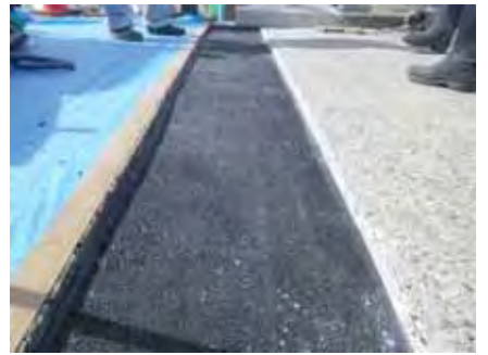
⑥下層転圧完了 17
