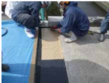
②シート貼付け
