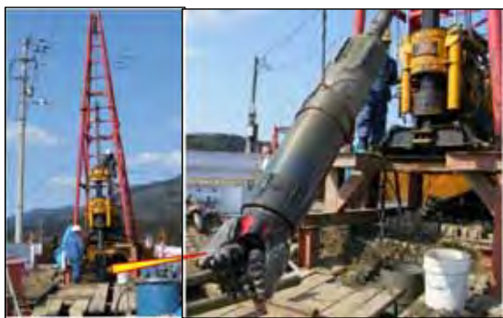
従来工法 (ロータリー式トリコンビット工法)
