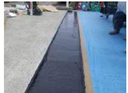
③ラッピングシート(上層)完了
