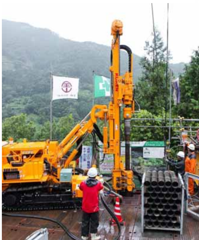
写真-1 セミディープウェル工法 施工状況
