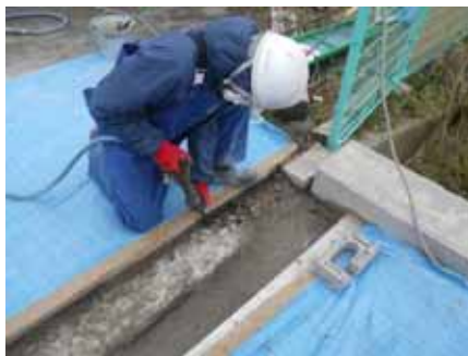
②ブレーカー・チップーはつり
