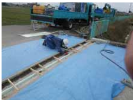
①型枠設置
