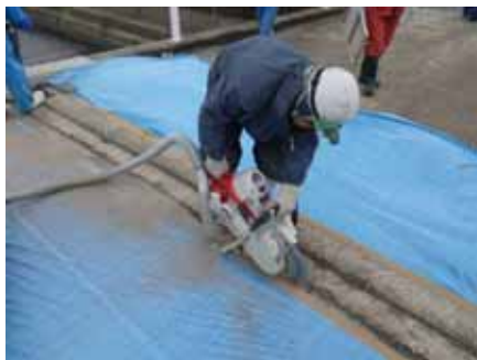
①エンジンカッター切断
