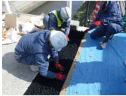
②ブチルゴム合材敷均し
