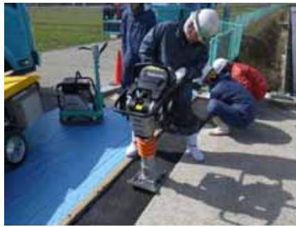
⑤ランマによる二次転圧
