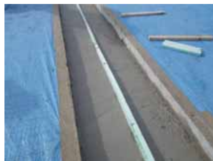
③不陸整正材打設完了 ※路盤や隙間は充填。
