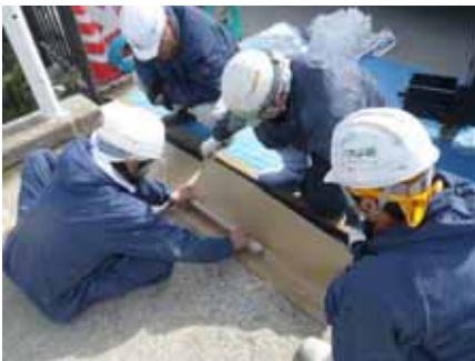
①シート貼付け
