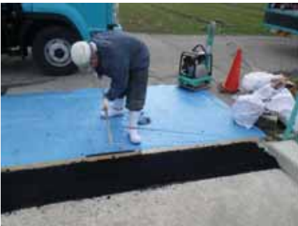
②ブチルゴム合材敷均し
