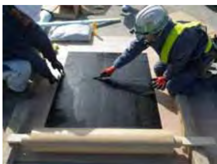
①シート切断(幅0.33m)
