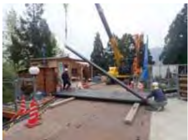
保孔管挿入状況
