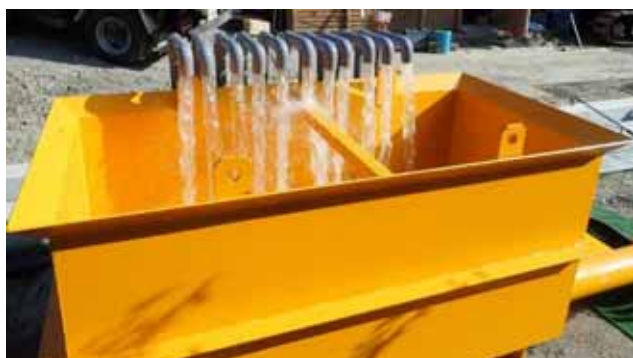
写真-2 セミディープウェル工法 排水状況
