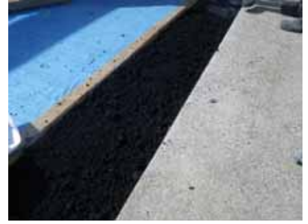
③ブチルゴム合材敷均し完了
