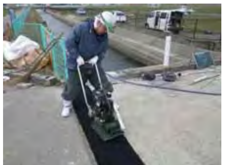
③プレートコンパクターによる一次転圧 18
