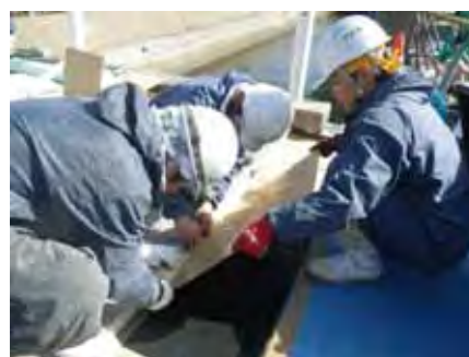
③シート貼付け 16
