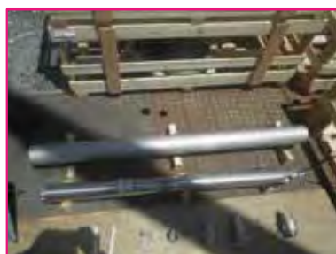
水中ポンプ設置状況
