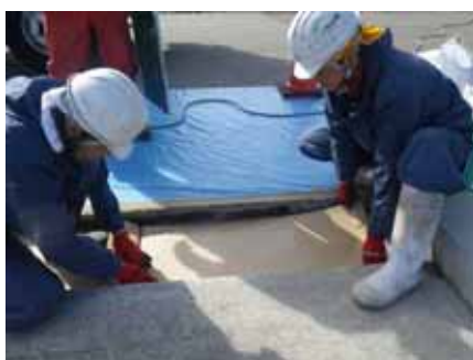
②シート貼付け
