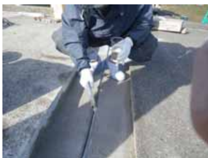
②プライマー塗布
