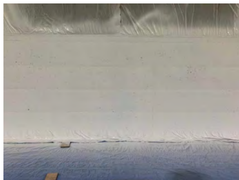
中塗り工 完了
