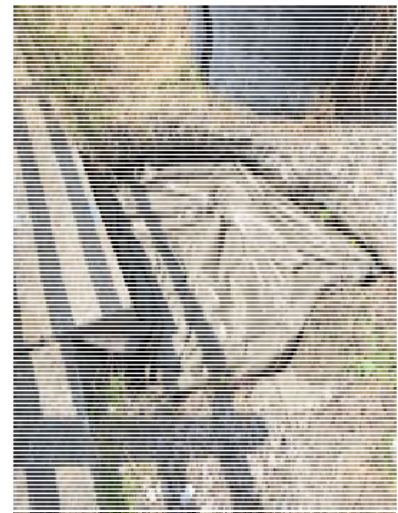
上部 縦1,000mm横1,000mm高さ1,300mm の空洞充填
