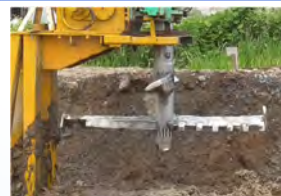
CMS攪拌翼中圧噴射状況
