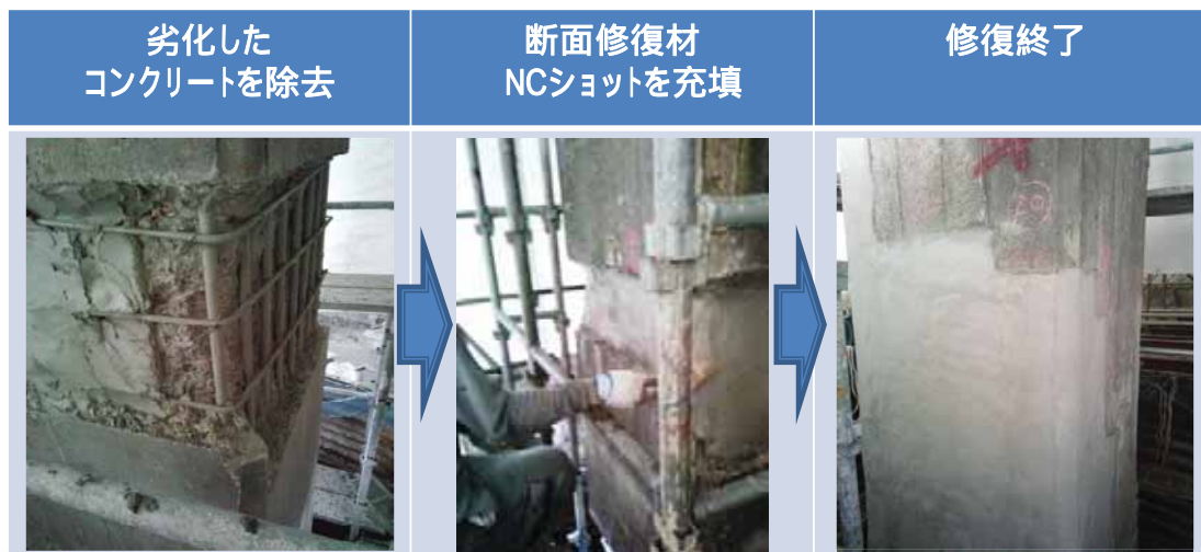
NCショットM 九条跨線橋橋梁修繕工事(H25.10)
