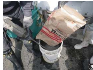
③ 材料の混練 (ハンドミキサー等により攪拌)
