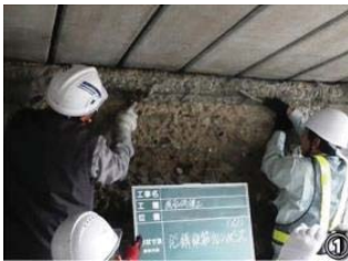
① コンクリート面の清掃
