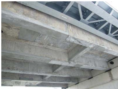
施工例 (床版下面の補修)
