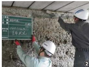
② プライマー処理
