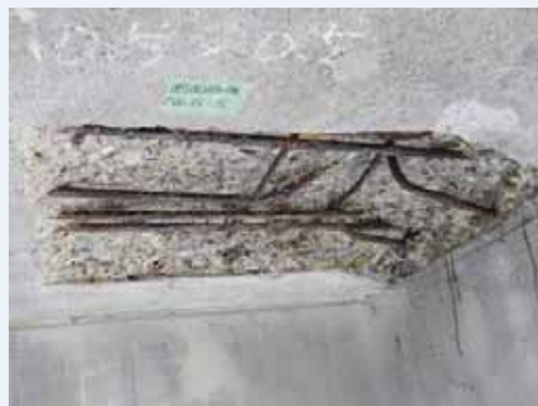
上新入直方線御館橋耐震補強工事 (H25.9)
