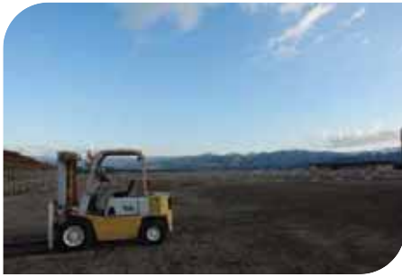
パネル設置前の全面防草
