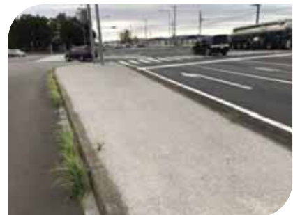
路肩部の防草例
