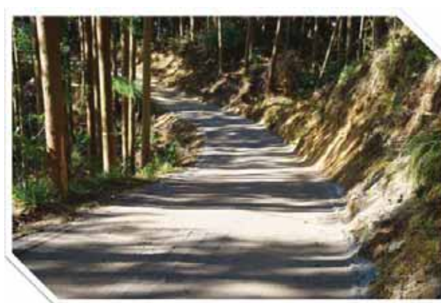
施工例：林道 (車両交通の少ない林道)
