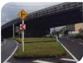
中央分離帯 施工前
