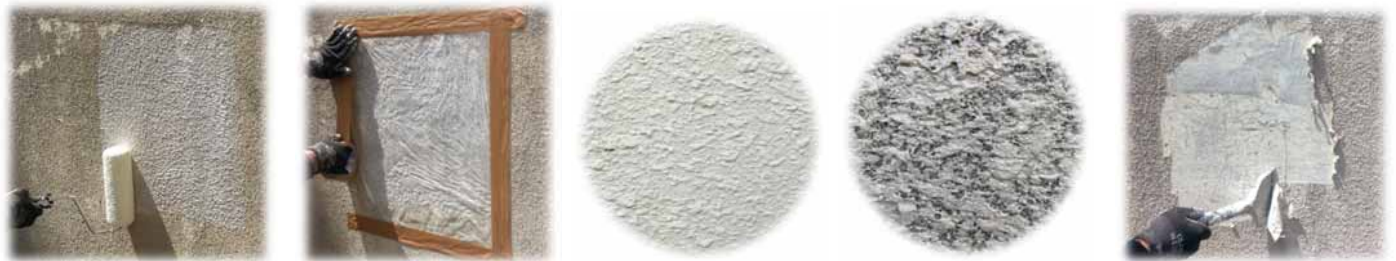
ローラーによる塗布作業
