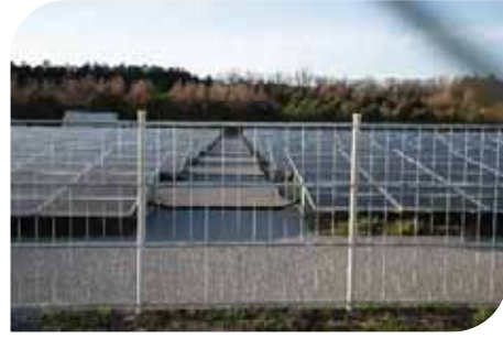
供用後の通路部防草
