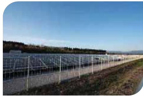
供用後の通路部防草
