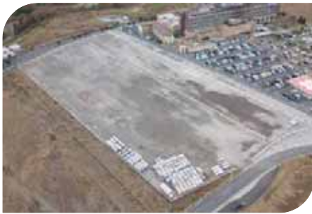
パネル設置前の全面防草
