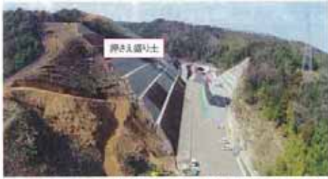
写真② ■ 変状が生じた重山地区の斜面。2018年2月末撮影
