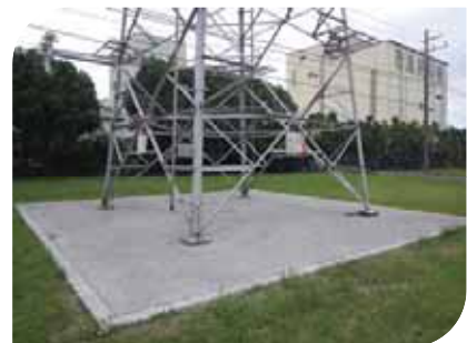
鉄塔下部の防草例
