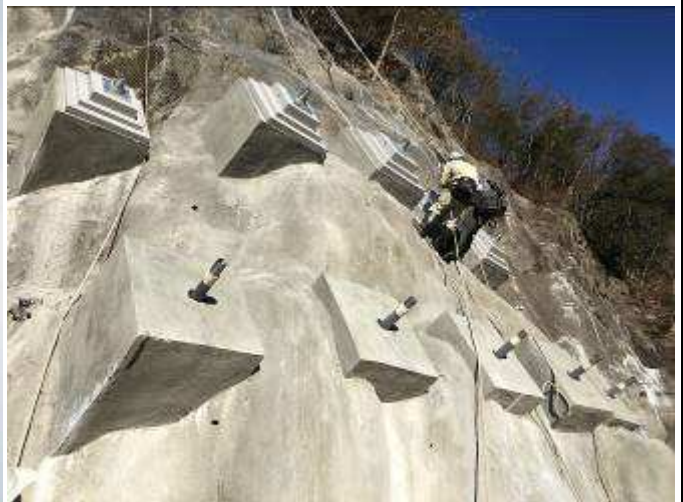
施工事例 (高所の岩盤崩壊対策)
