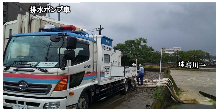
▲ 緊急排水作業にあたる排水ポンプ車（人吉市九日町）
