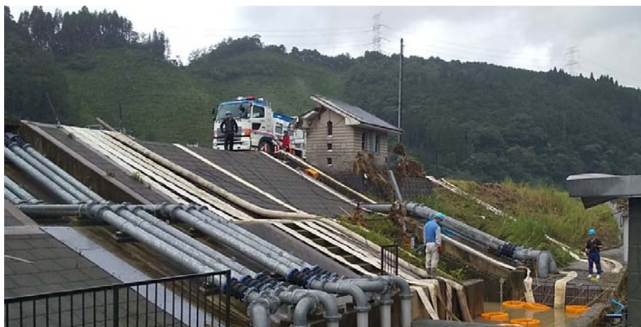
▲ 排水作業のためホースを設置する協力企業（球磨村渡）
