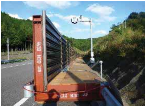
【写真－3 設置状況】
