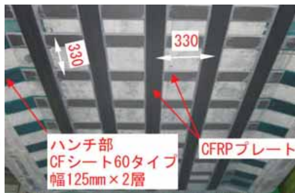
図-4 床版下面格子貼り補強状況
