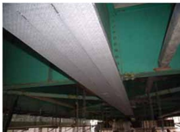
図-8 鋼桁補強事例
