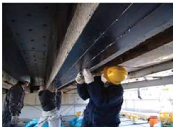
図-7 コンクリート桁補強事例
