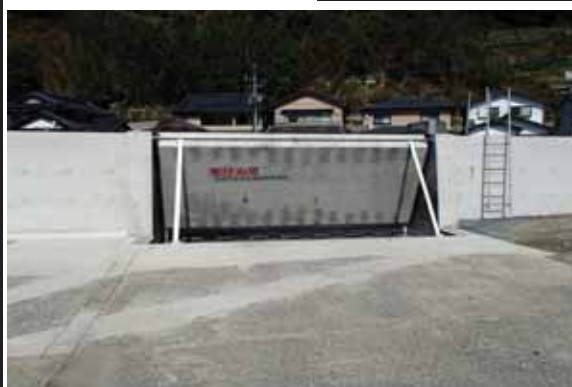
浮体式陸閘ゲート閉扉状態
