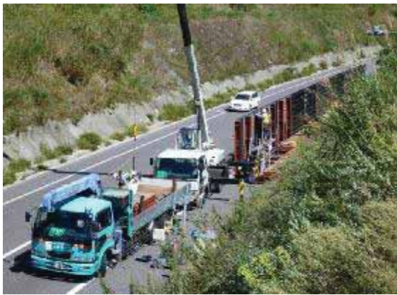
【写真－2 施工写真】
