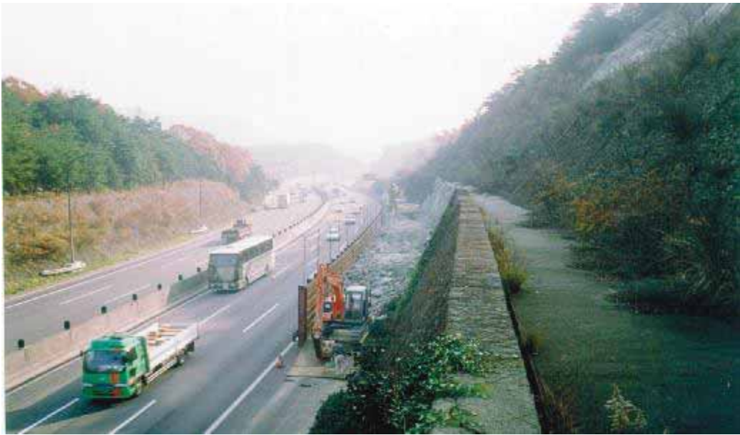
【写真－1 施工写真】
