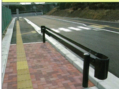
⑤障害物(防護柵)
