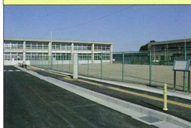
⑦障害物(電柱)
