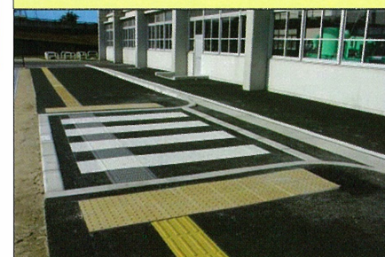
③ 波打ち歩道
