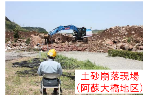
遠隔操縦による復旧作業例
