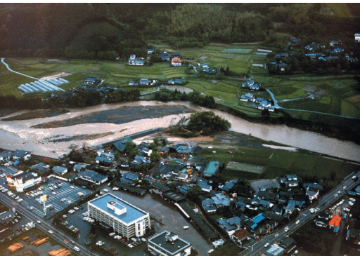
昭和63年（緑川支川御船川）
