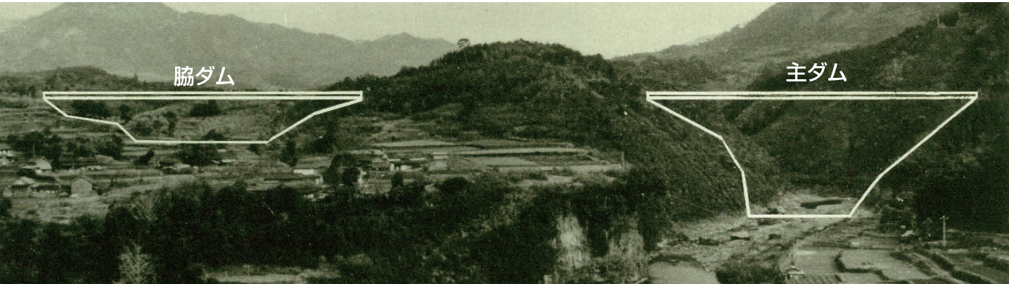
建設前の緑川ダム予定地
