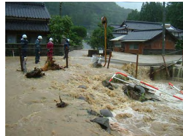
緑川上揚付近被災状況 (平成19年7月出水)(29K付近右岸)
