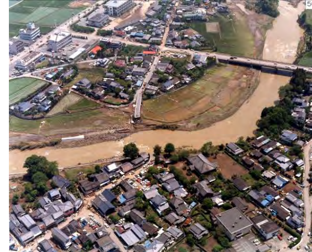
御船川眼鏡橋の状況(昭和63年5月出水)
