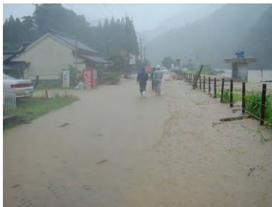
上揚付近被災状況(29K右岸付近)
