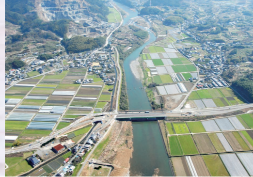
中流部(28km付近 鶉ノ瀬堰)
