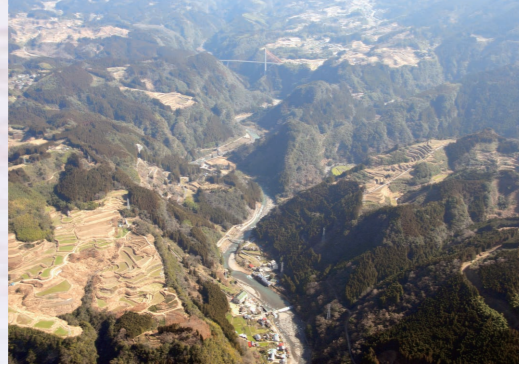
上流部(50km付近)
