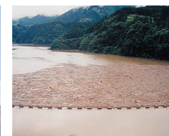
網場 貯水池に流れ込んだ流木やゴミ類を、ダム堤体の上流で止める
