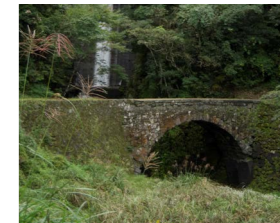
③ 雄竜滝橋 (美里町)
