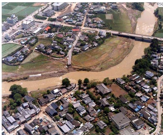
御船川眼鏡橋の状況 (昭和63年5月出水)
