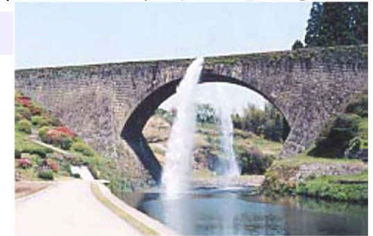
通潤橋(山都町) 国指定重要文化財
