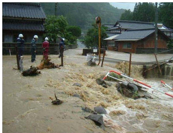
緑川上揚付近被災状況 (平成19年7月出水) (29K付近右岸)
