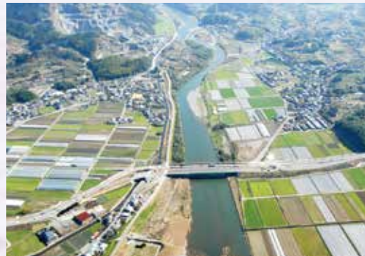
中流部(28km付近 鶴ノ瀬堰)
