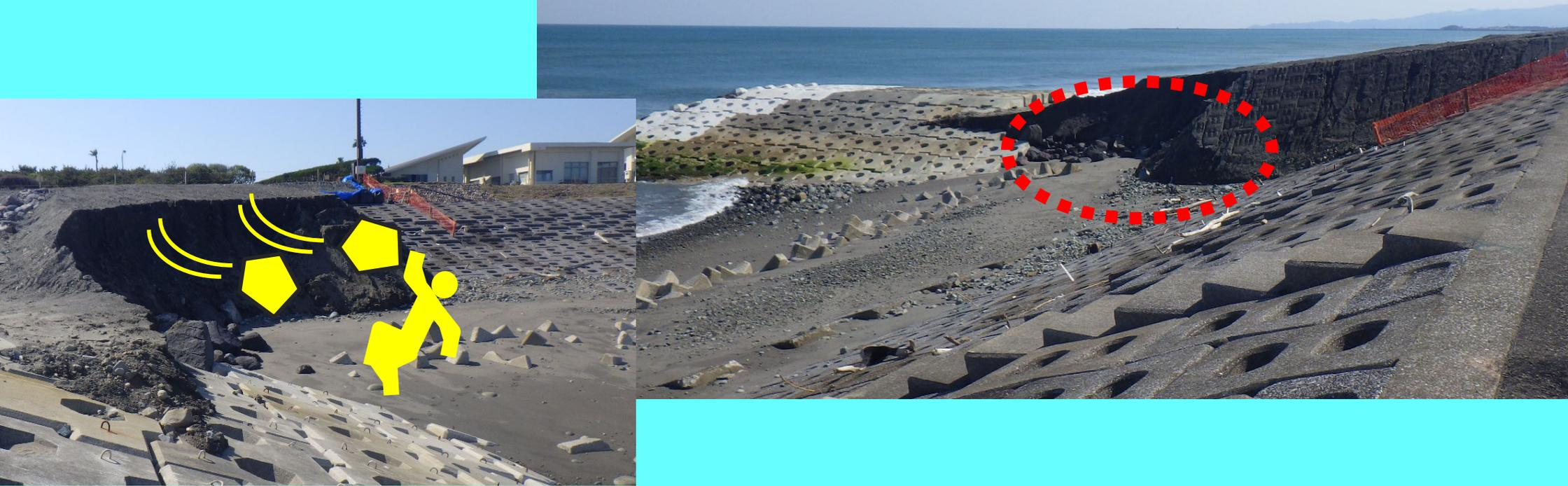
砂浜を回復させるため、突堤周辺に川砂利等の養浜を実施しています。波により海中に土砂を供給するものです。そのため、波の影響で崩落の恐れがありますので、周辺を立ち入り禁止区域としています。
