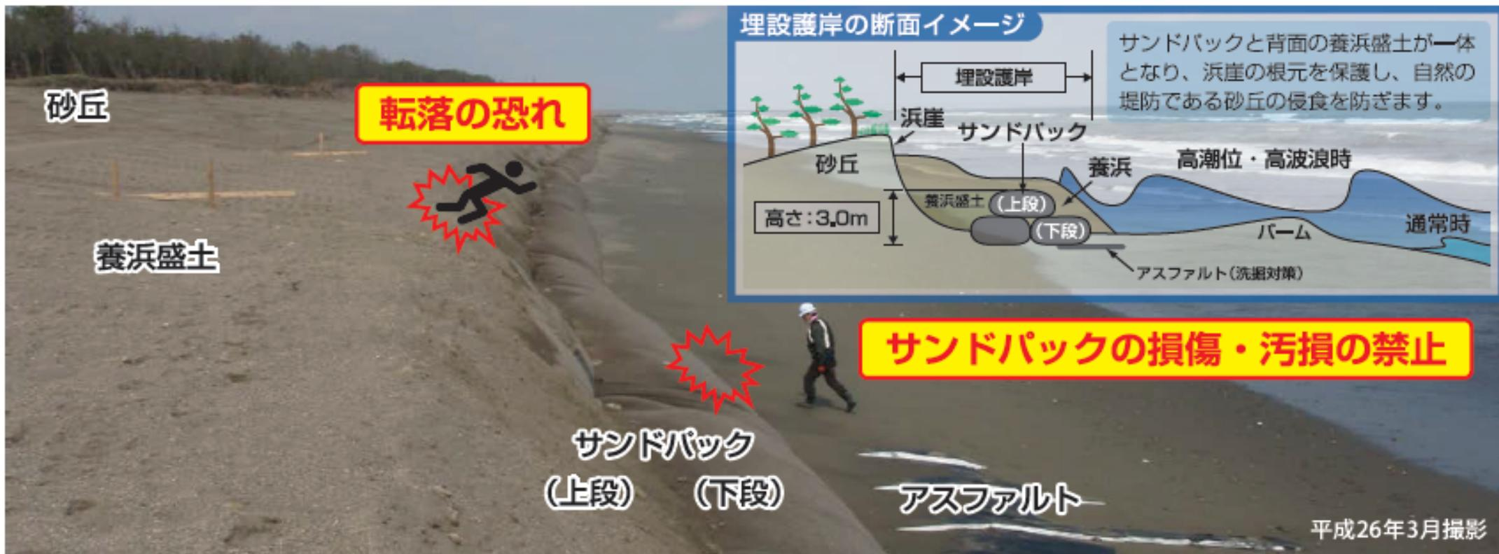
サンドバックは丈夫な合成繊維でできていますが、先のとがったもので刺したり、鋭利な刃物で切ったり、たき火・花火・タバコの吸い殻等の火種を近づけると、サンドバックが損傷し、サンドバックや背後の養浜盛土が崩壊する恐れがありますので、これらの行為をしないでください。
