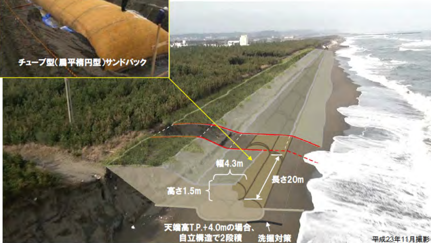
サンドパック工法を適用した埋設護岸の整備イメージ(大炊田地区北側の鳥瞰)
