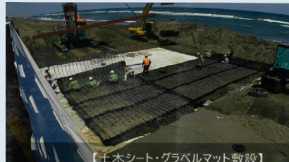
埋設護岸(サンドバック工法)について【下段完了】
