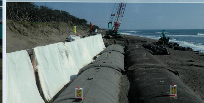
埋設護岸(サンドバック工法)について【下段完了】
