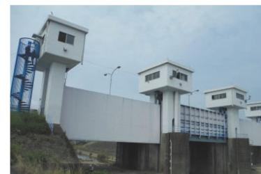
出水時には水門を閉じて、本川の水が支川へ流れ込むのを防ぎます。
