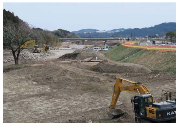
本庄川かわまちづくり整備状況(綾町)
