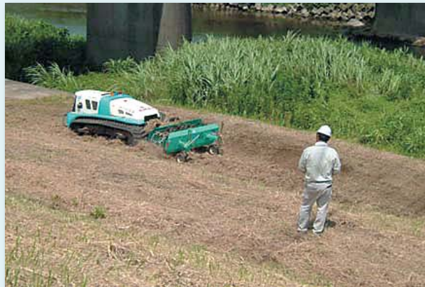
機械を使用した除草工事
