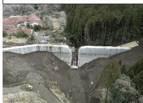
②①皇子川1第3砂防堰堤(R4.3完成)
