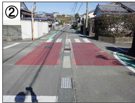
カラー舗装（改良）
