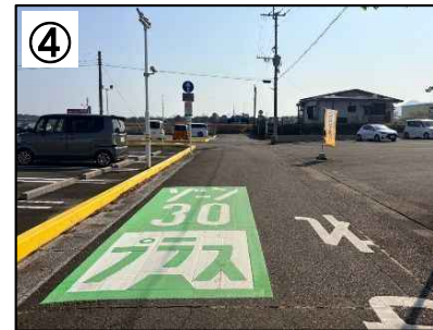
ゾーン30プラス看板・路面表示
