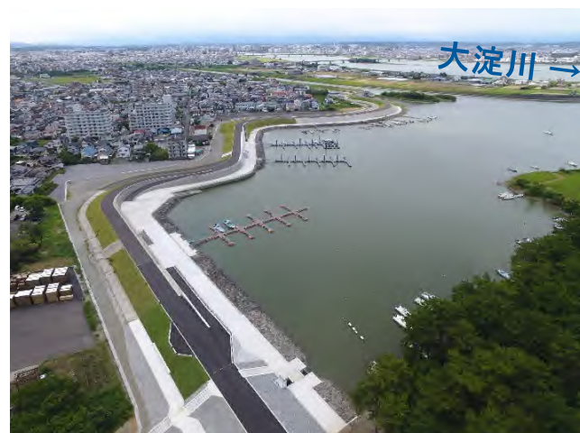
○津屋原沼地区の堤防（令和4年完成）
