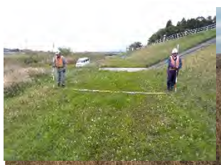
○堤防点検状況
