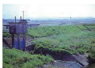
○河川管理施設（樋門）
