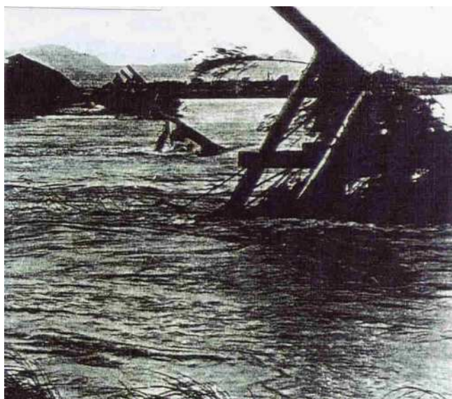
流失した高松橋 (宮崎市)
