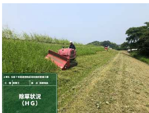
写真 5.2.3 堤防除草状況
