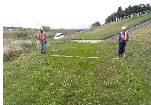
写真 5.2.4 堤防点検状況
