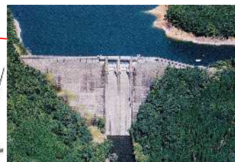
■綾南ダム(昭和 33 年完成)
