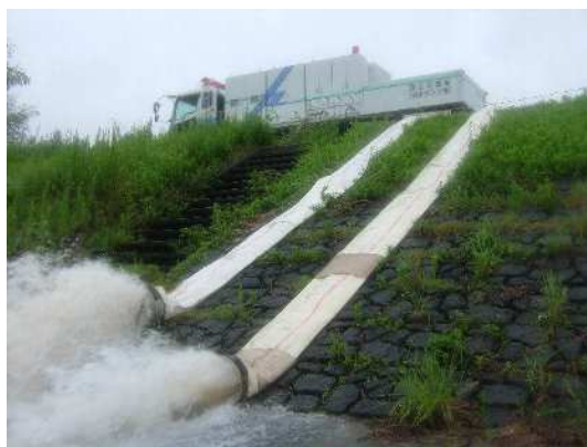
写真 5.2.9 排水ポンプ車による排水活動
