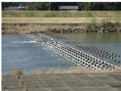
写真 2-1-8 床止め (小丸川床止め：小丸川)
