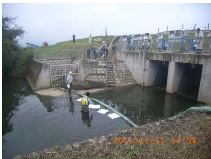
写真 4-3-16 オイルフェンス、吸着マットの設置状況 (水質事故訓練にて)
