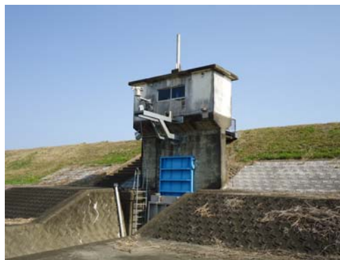
写真 2-1-9 樋管 (持田樋管：小丸川)
