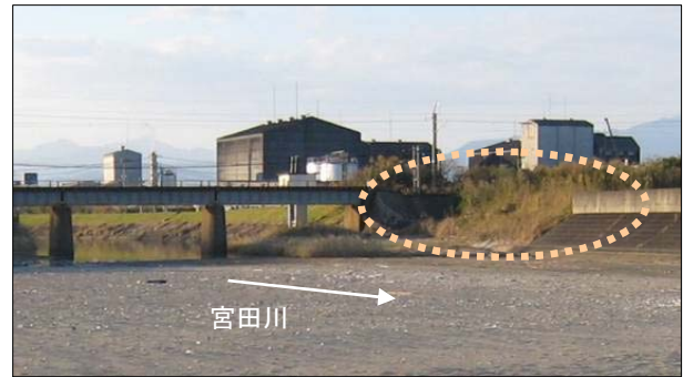
写真 2-1-5 堤防の未整備箇所の状況 (宮田川)
