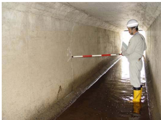
写真 4-3-4 樋門の保守点検
