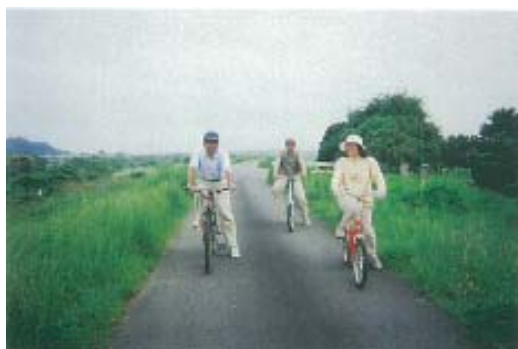
写真 2-2-1 堤防・高水敷の利用状況
