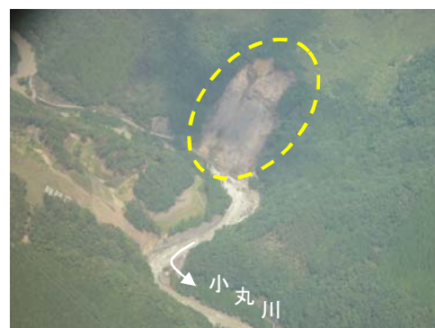
写真 2-1-7 小丸川上流部の山腹崩壊状況
