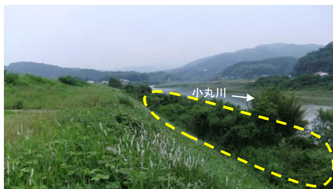
写真 2-1-6 河道内に繁茂する樹木群
