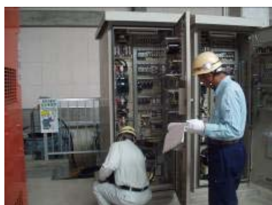
写真 4-3-5 電気設備の点検状況
