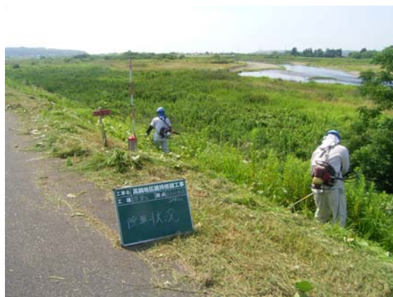
写真 4-3-3 堤防除草作業
