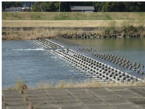
写真 2-1-7 床止め (小丸川床止め : 小丸川)
